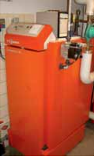
Bodenstehender Brennwertkessel (links) mit großem und wandhängende Brennwerttherme (rechts) mit kleinem Wasserinhalt.
