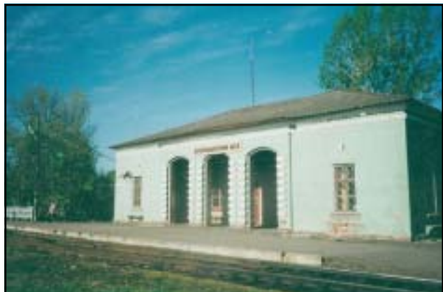
Станция колеи 1520 «Васильевский мох»
