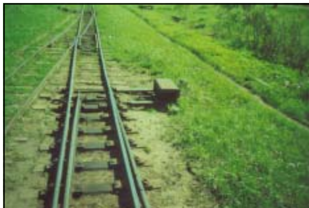
5-й пост. Автоматическая стрелка
