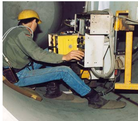
Bild 9-3: Unterpulverschweißen, ein schadstoffarmes Verfahren
