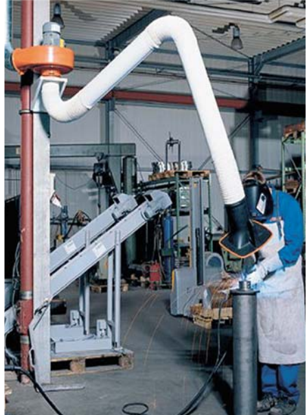
Bild 9-6: Beispiel einer stationären Absaugung
