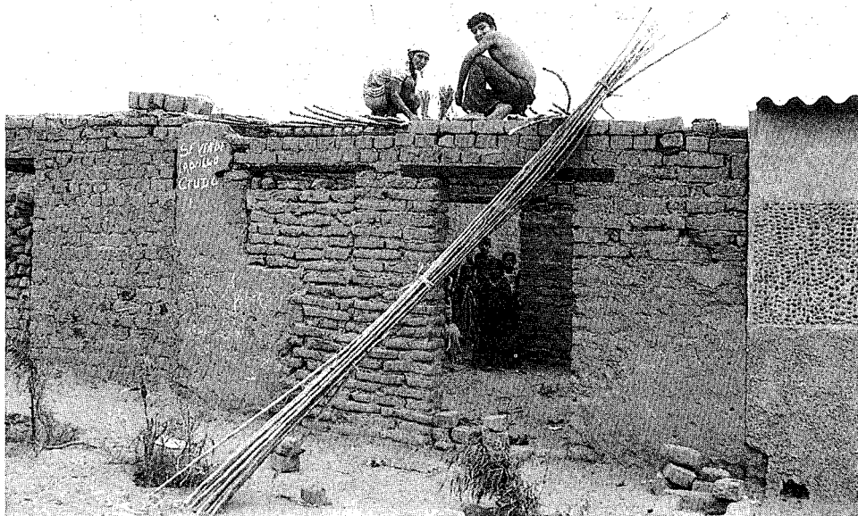
Foto No. 9.— Confección de un techo de torta de barro, La Esperanza, Trujillo (cliche J. Pineda).
