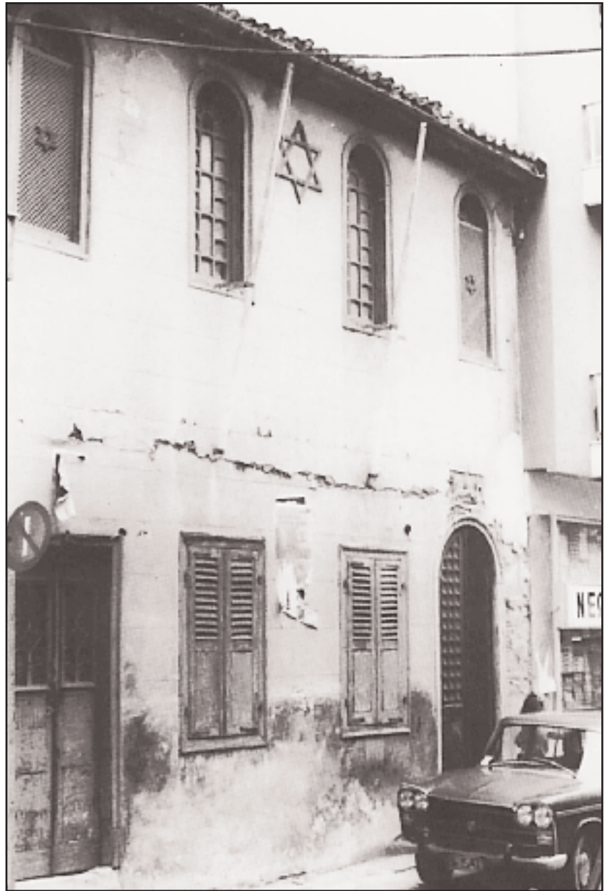
Η συναγωγή της Πάτρας, κτίσμα του 1926. Η φωτογραφία είναι τον Νοέμβρη του 1978, δύο χρόνια πριν από την κατεδάφιση. Κύρια είσοδος ήταν η δεξιά, ενώ η άλλη, η αριστερή της φωτογραφίας, οδηγούσε στο γραφείο και το σπίτι του ραββίνου.
