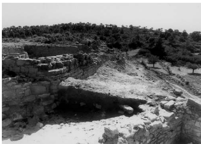
Fig. 247: Derrumbe de adobes de la muralla (cata 14)
