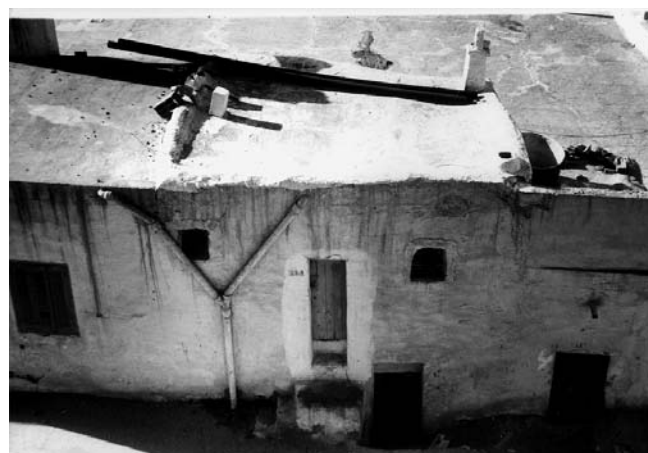
Fig. 310: Laghuat (Argelia): Semi-sótano y escalera adosada
