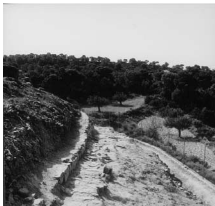
Fig. 63: Entrada occidental: camino de acceso
