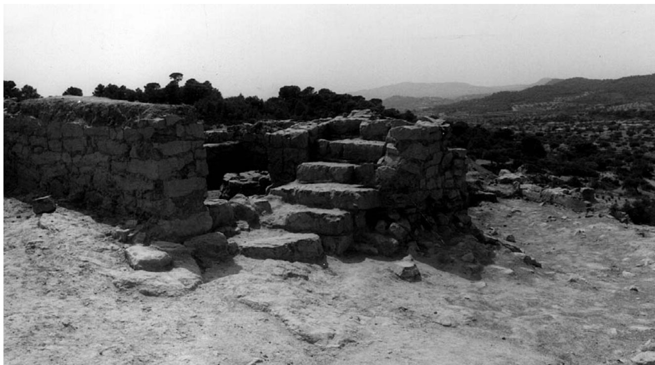
Fig. 299: Departamento 12: Escalera exterior
