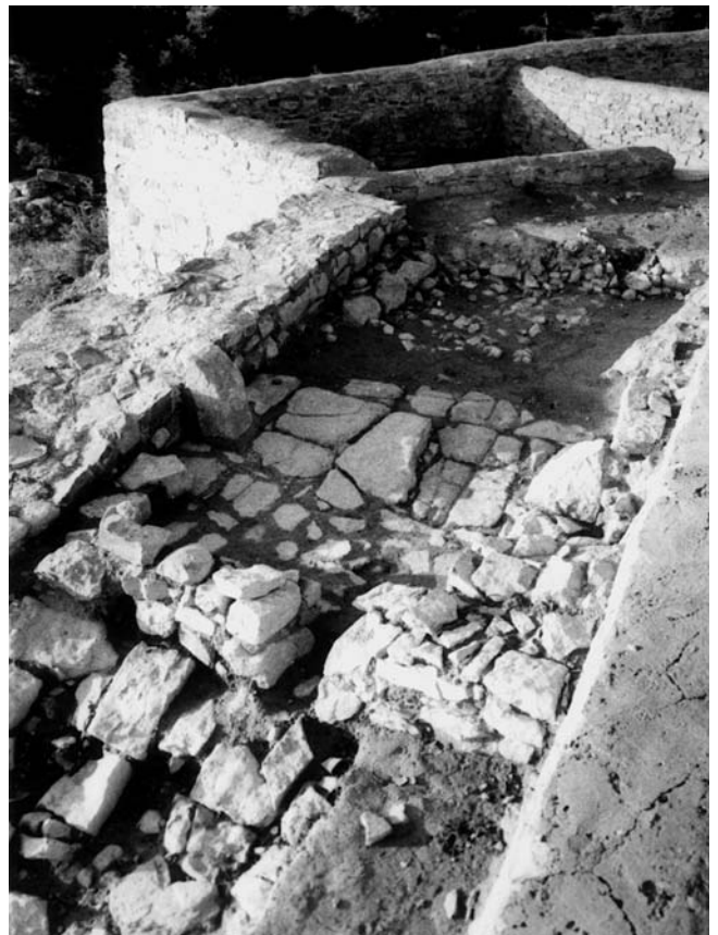
Fig. 5: La calzada de acceso en la puerta
