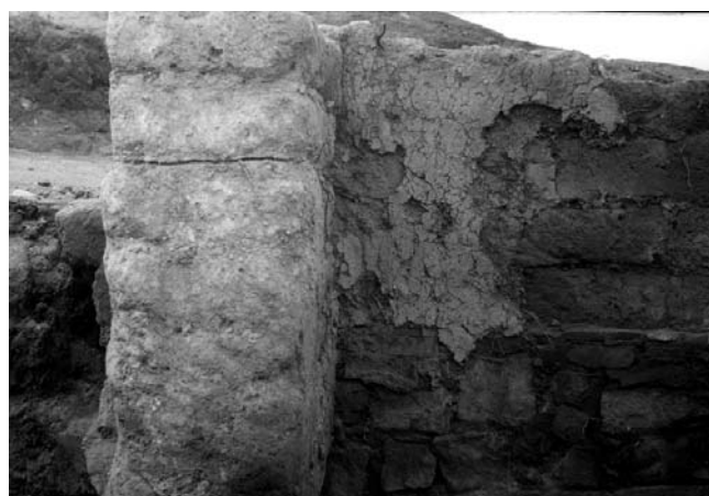
Fig. 250: Departamento 1: Paramento de adobes enlucido y pintado
