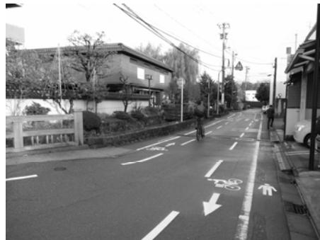
**写真 II-12** 自転車、歩行者双方の通行空間を路面表示により明確化した事例
