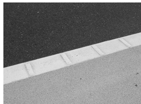
写真 II-8 道路標示「車両通行帯」を凹凸のついた仕様とした事例
