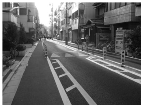
**写真 II-13** 車道部分にハンプを設置しハンプの両側にゴム製ポールを設置した事例
