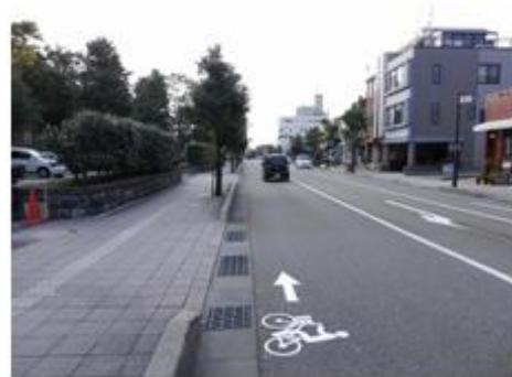
写真 II-10 ピクトグラムを設置した事例
