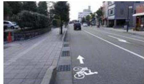
写真 I-3 車道左側部の車線内にピクトグラムを設置した事例
