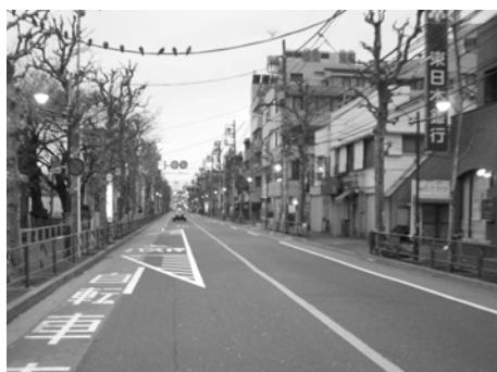
写真 II-18 バス停を示す路面表示を設置した事例
