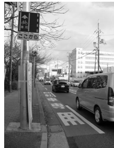
写真 II-7 道路標識「普通自転車専用通行帯(327の4の2)」と道路標示「専用通行帯(109の6)」を設置した事例
