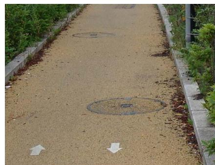
写真 II-3 マンホールの蓋に滑り止め加工している事例
