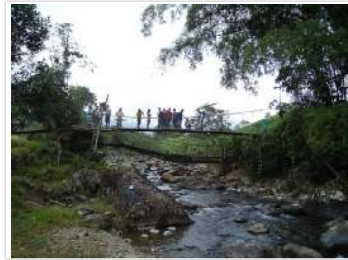
Pedregal & Lorena 08.08.2007 Pichincha, Ecuador 37.29m
