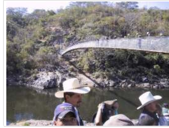
Puente Internacional 19.12.2000 Lempira, Honduras 137.01m
