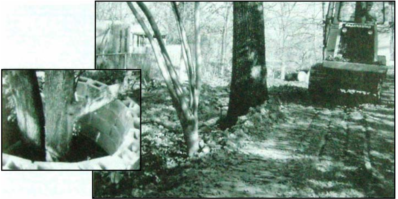
FIGURA 7.12 Protección de árboles valiosos durante las operaciones de remodelación del paisaje. Aún una capa delgada de suelo esparcida sobre el sistema radicular de un árbol grande puede sofocar las raíces y matar al árbol. (Inserto) Para preservar la superficie original del terreno, para que las raíces activas puedan aprovisionarse de suficiente oxígeno, puede construirse una fuente seca de ladrillos u otro material decorativo. La fuente seca puede incorporarse al diseño final del paisaje, o rellenarse a razón de pocos centímetros por año. (Fotos cortesía de R. Weil)
