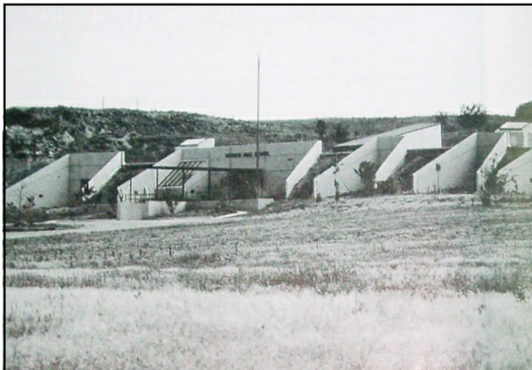
FIGURA 7.23 Esta escuela superior de Oklahoma ha sido construida dentro del suelo, con un solo lado expuesto. Este diseño aprovecha el alto calor específico y la baja conductividad térmica del suelo circundante, manteniendo la escuela tibia en invierno y fresca en el verano, con un gasto mínimo de energía para calefacción o acondicionamiento de aire. (Foto cortesía de R. Weil)
