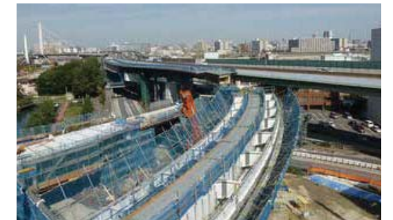
阪神高速 大和川線工事(築港八幡町地区)
