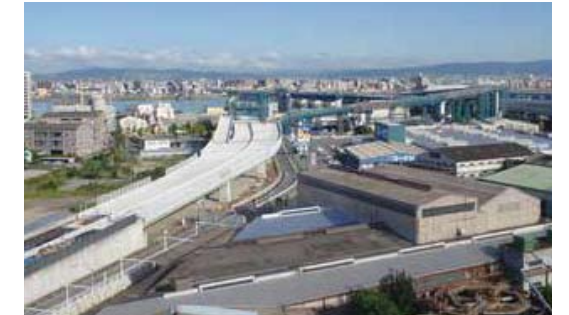
阪神高速 淀川左岸線1期工事(高見工区)
