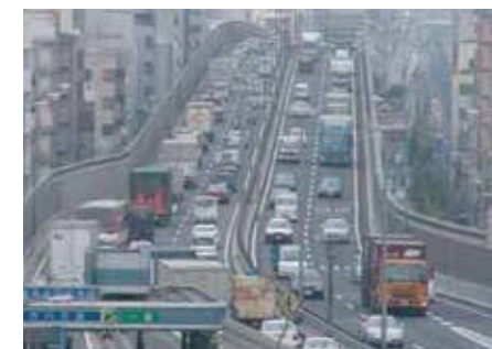
阪神高速 東大阪線(高井田付近)
