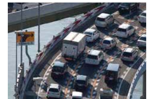
阪神高速 守口線・環状線合流部
