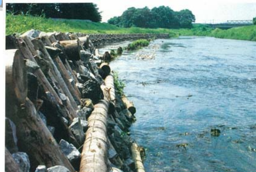
小畔川・木工沈床 (埼玉県・平成3年施工)
