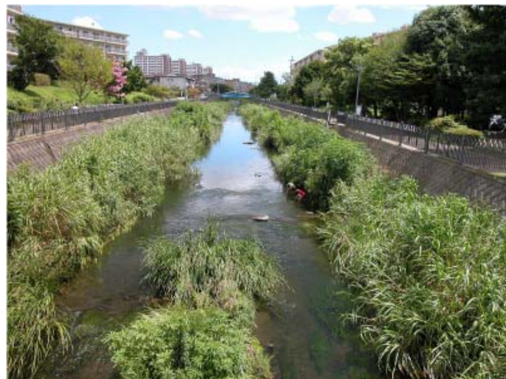
いたち川（横浜市・昭和57年施工・平成16年撮影）
