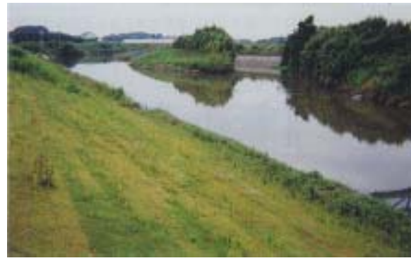
芝張り工法施工事例 (滝川)
