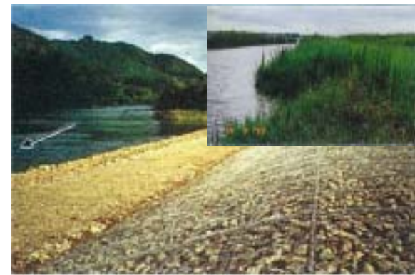
カゴマット工法施工事例
