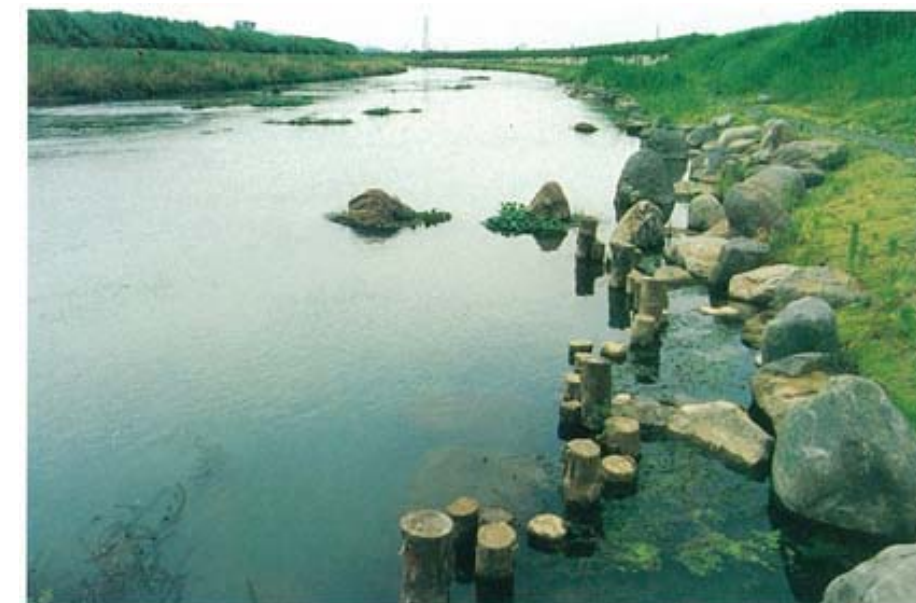
矢形川・捨て石+乱杭 (熊本県・平成3年施工)
