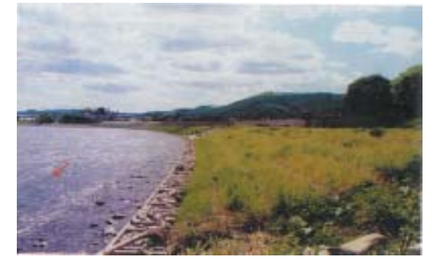
木工沈床施工事例 (湧別川)
