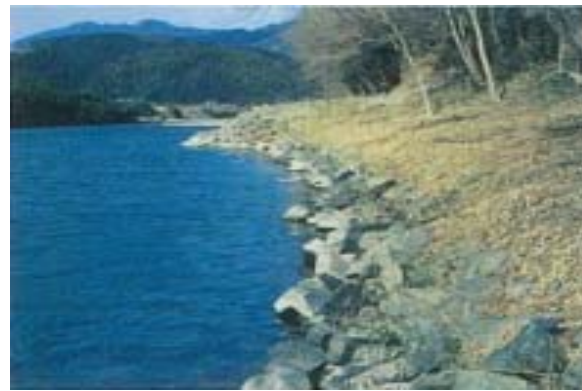
捨石工法施工事例 (脛川)
