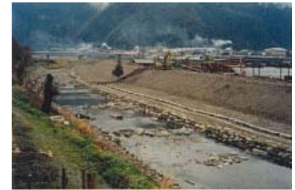
空石積施工事例 (八東川)
