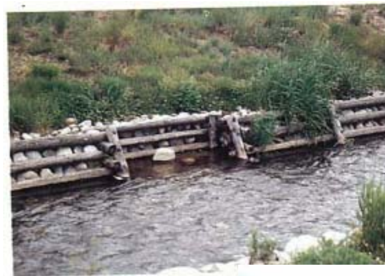
農具川・木工沈床 （長野県）
