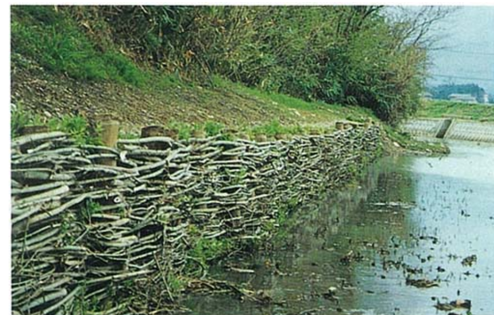
堤沢川・粗朶柵工 (新潟県・平成3年施工)
