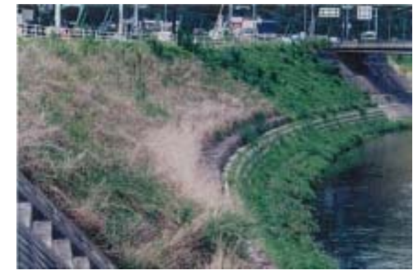
植生ブロック施工事例 (巖木川)
