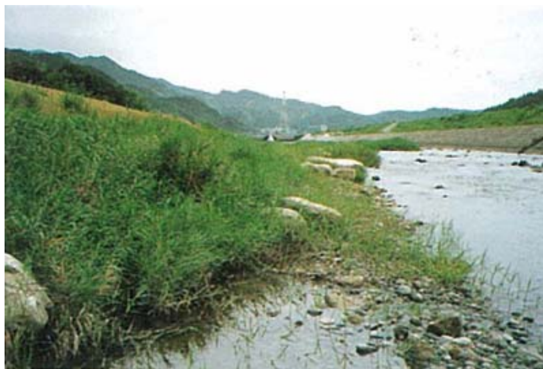
巖木川・法枠ブロックに覆土を施し護岸 (佐賀県・平成6年施工)
