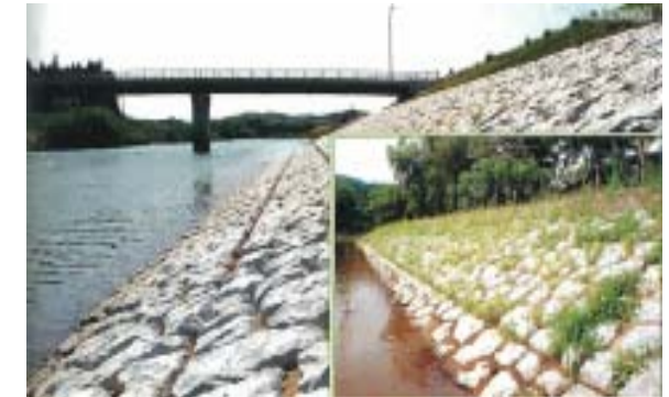
接続ブロック施工事例
