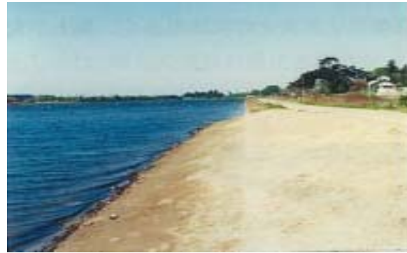
覆土工法施工事例 (鶴生田川)
