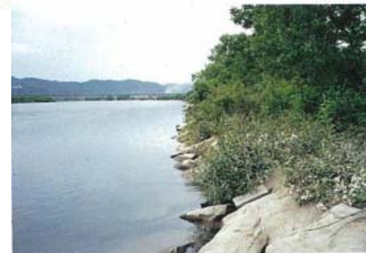
高梁川・捨石工 （岡山県）
