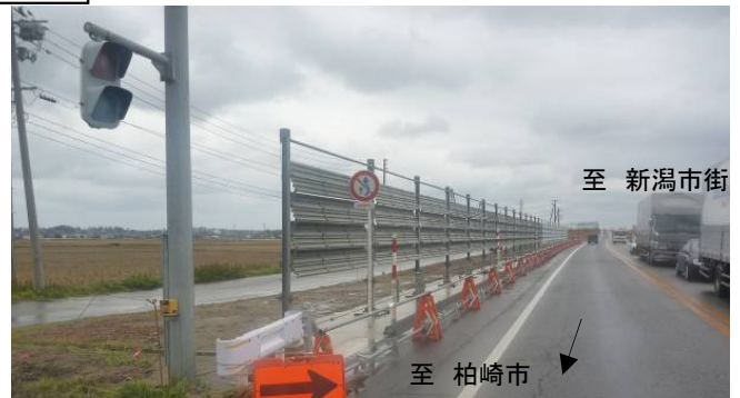
防雪柵設置後
