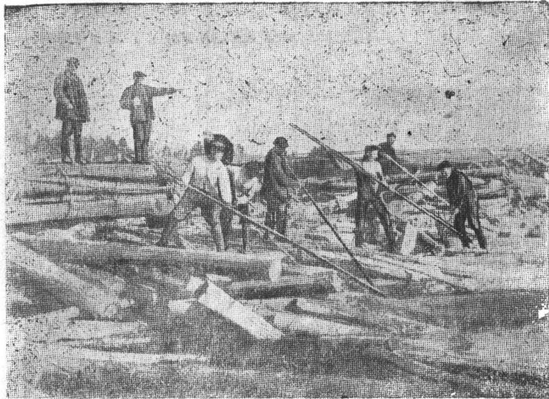
Бригада сплавщиков по р. Еме Г. И. Туезова за разборкой залома на первичной Голуздинско й запани.
