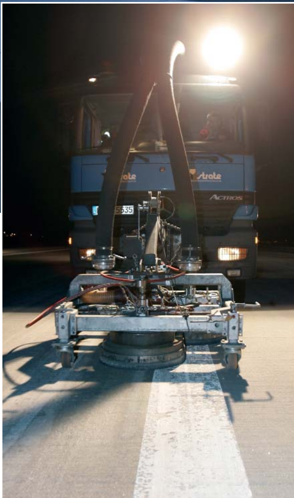
Erst muss das alte Zeug weg: Mit Hochdruck werden die verblassten Farbschichten abgetragen.
