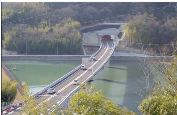
峯相大橋から石倉トンネル起点側を望む
