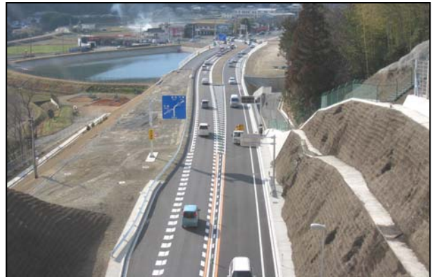
石倉トンネル終点側から下伊勢ランプを望む
