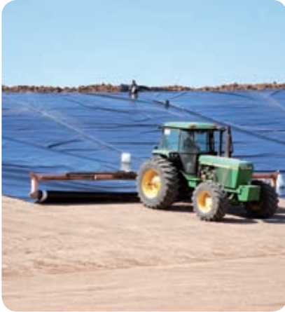
למעלה: מחפר הורס בית גידול של קנים בנחל שורק. למטה: איטום מאגר ביריעות פלסטיות. צילומים: עודה חדד
