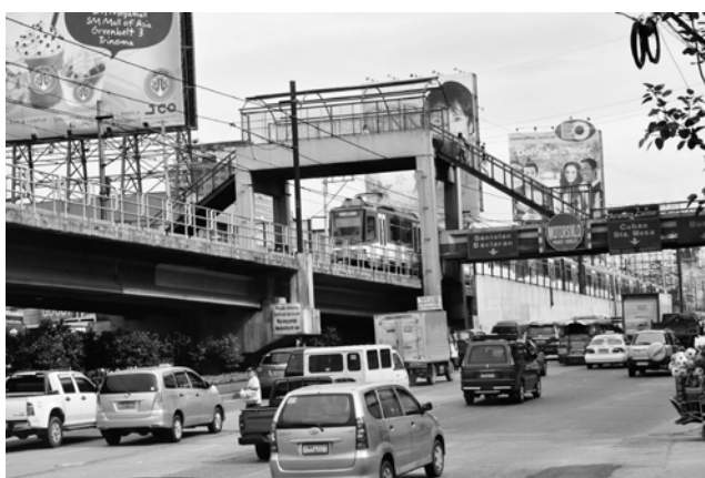
鉄道の上にある2段式歩道橋
