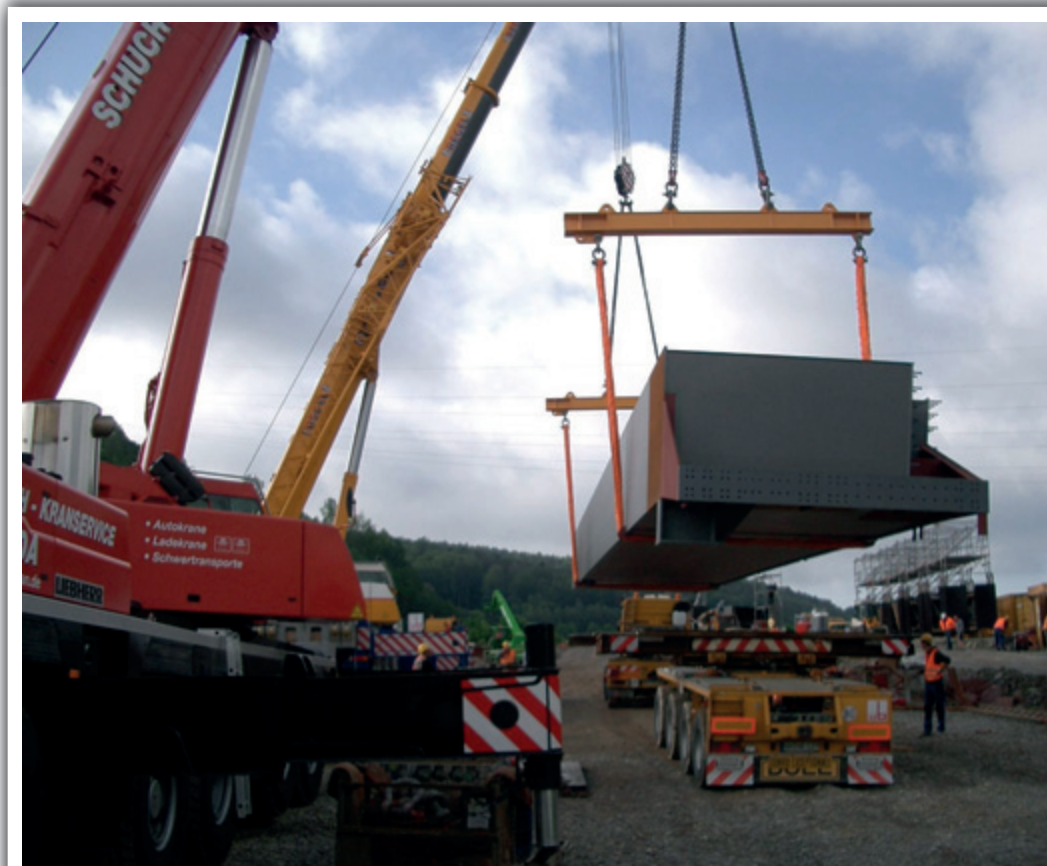
Bild 11: Antransport der ersten Stahlteile für den Überbau
