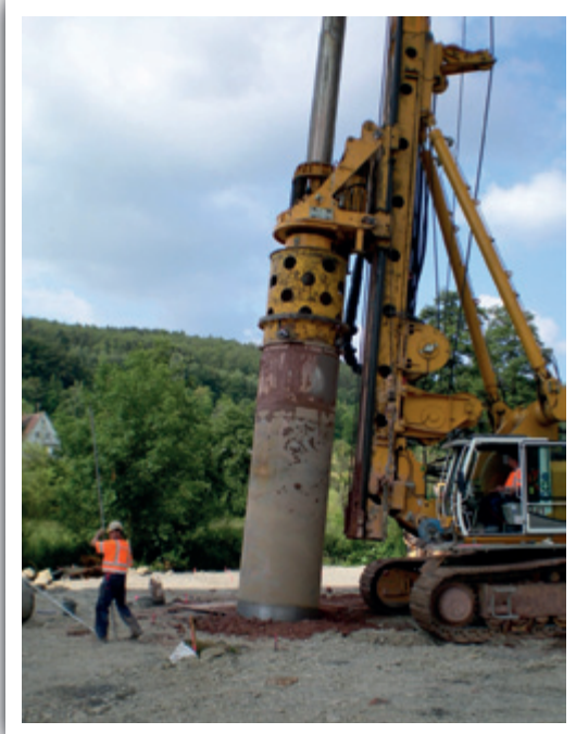
Bild 6: Herstellung Bohrpfähle
