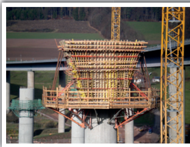
Bild 10: Pfeilerkopfschalung
