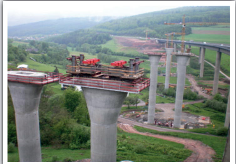
Bild 13: Pfeilerkopf mit Verschieblager
