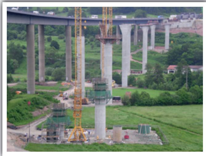
Bild 9: Herstellung Pfeiler mit Kletterschalung
