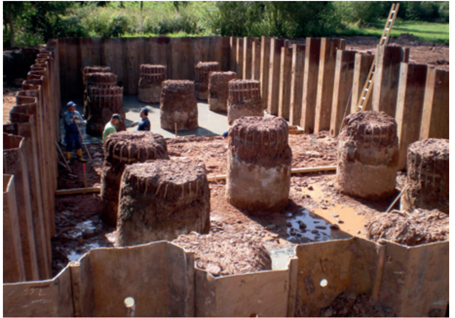
Bild 7: Tiefgründung Pfeiler
