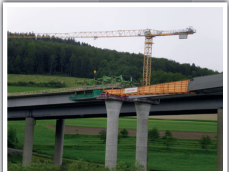
Bild 17: Einschub Stahlkonstruktion Überbau West
