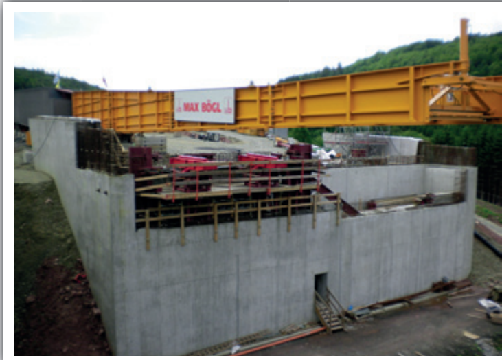
Bild 12: Widerlager Achse 90 mit Vorbauschnabel
