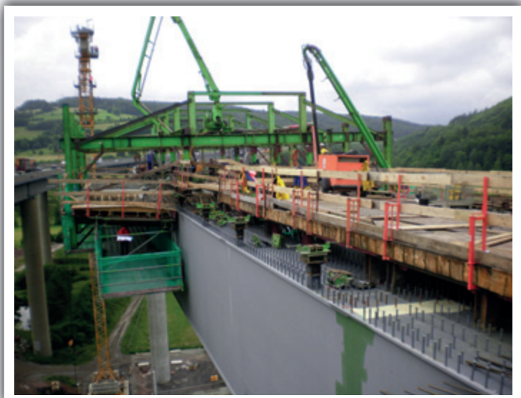
Bild 16: Fahrbahnplattenschalwagen Herstellung Fahrbahnplatte Überbau Ost
