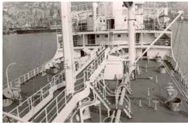
Particolare della coperta
