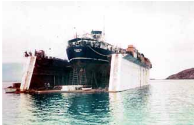
Ai lavori in bacino galleggiante 1950/51
