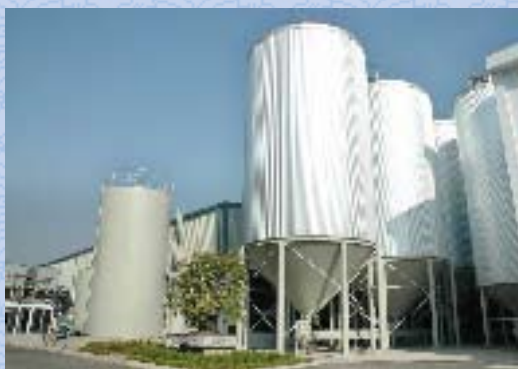
Hệ thống xử lý nguyên liệu cho nhà máy bia
