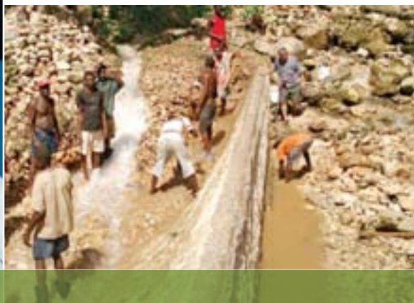
Réhabilitation du seuil déversoir à la centrale de Gaillard, en Haïti.
