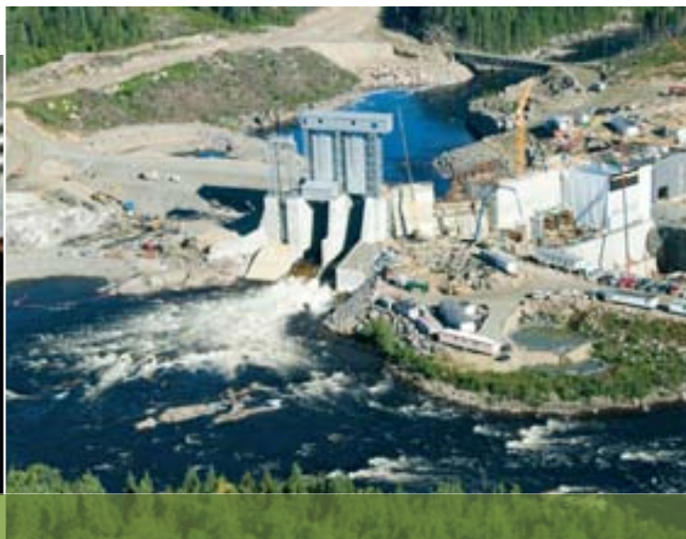
Construction de l'aménagement des Rapides-des-Cœurs, en Haute-Mauricie.
