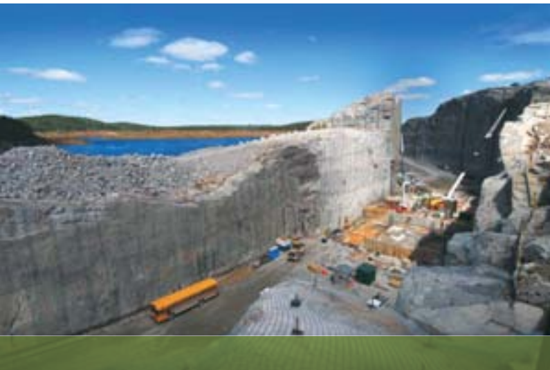
Construction de l'évacuateur de crues de la Rupert, à la Baie-James.
