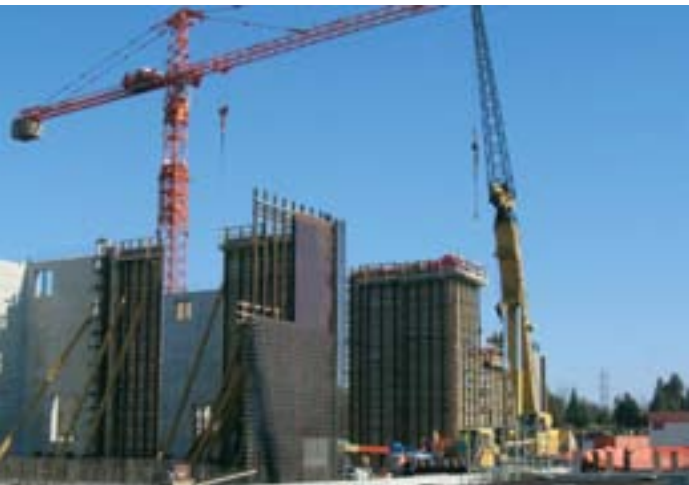
Érection des murs et de la structure de la partie des convertisseurs du poste de l'Outaouais.
