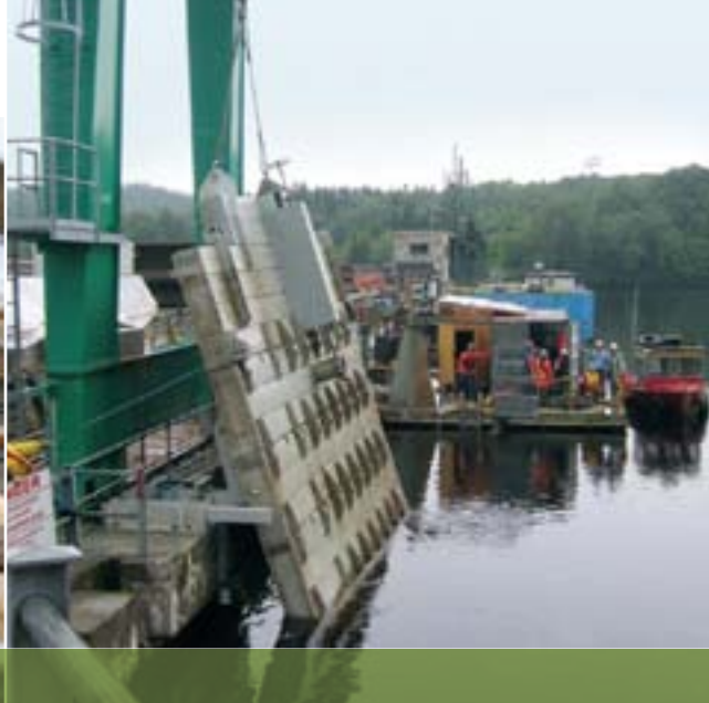
Sur le site de la centrale de La Tuque, mise en place d'un batardeau.
