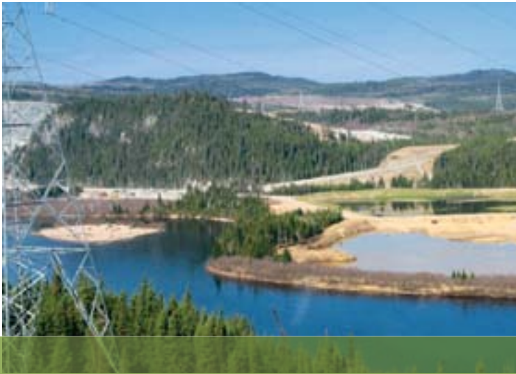
La centrale de la Péribonka est raccordée au réseau au moyen d'une ligne à 161 kV de 128 km.
