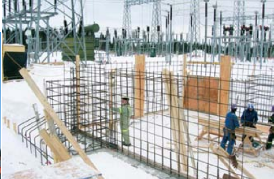
Réfection du poste de Hauterive, sur la Côte-Nord.
