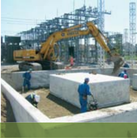
Au poste de Templeton, en Outaouais, travaux visant à augmenter la capacité de transformation.
