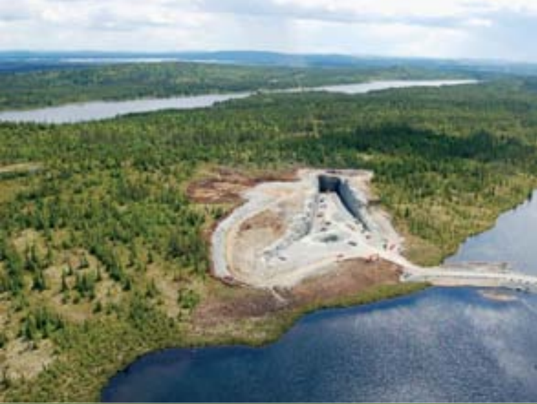
Construction du tunnel de transfert, élément clé de la dérivation Rupert.
