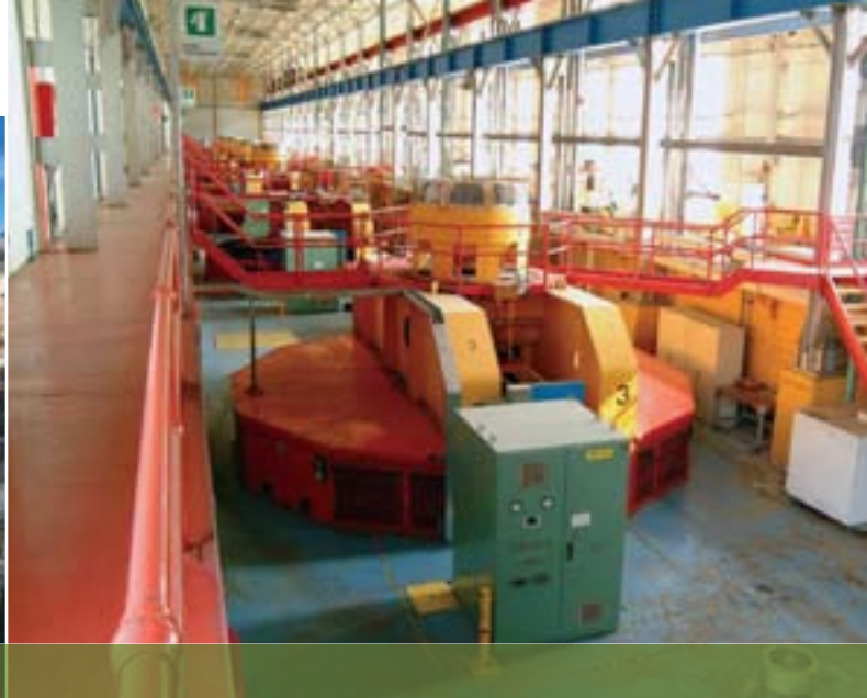
Réhabilitation de la centrale de la Rivière-des-Prairies, à Montréal.
