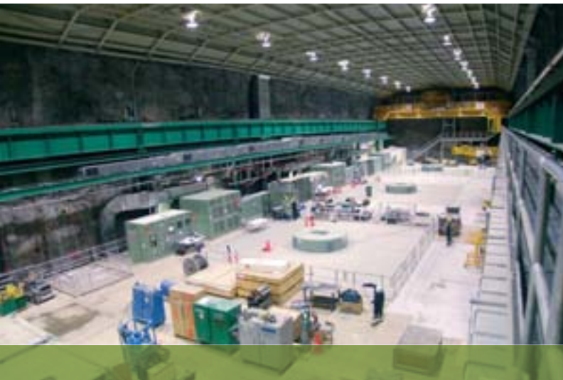
La centrale souterraine de la Péribonka, en construction.
