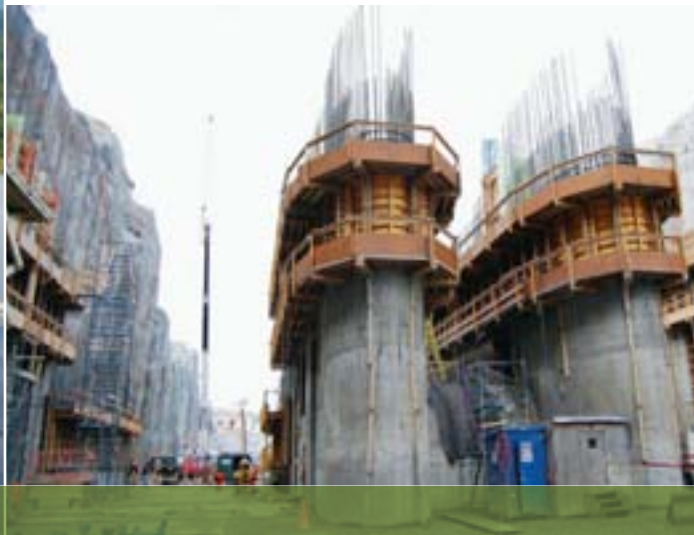
Construction de l'évacuateur de crues de la Rupert.
