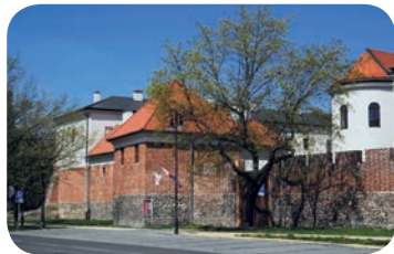
>>> Fragment murów obronnych przy ul. Wałowej
