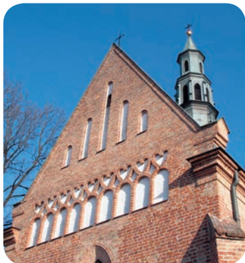
>>> Zachodni szczyt kościoła pw. św. Wacława
