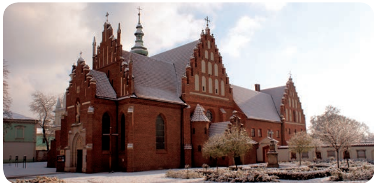
>>> Kościół i klasztor oo. Bernardynów - widok od strony ul. S. Żeromskiego
