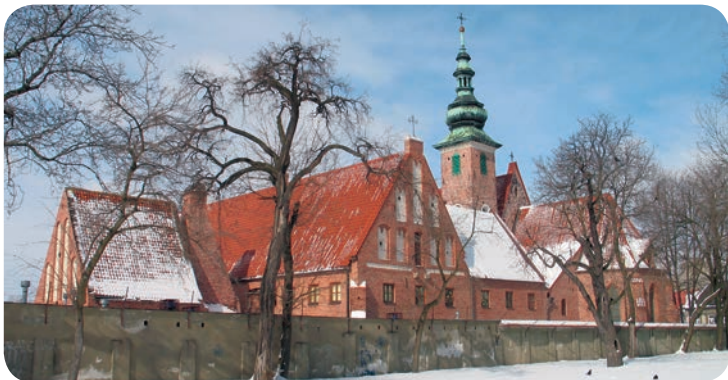
>>> Kościół i klasztor oo. Bernardynów, widok od strony ul. R. Traugutta
