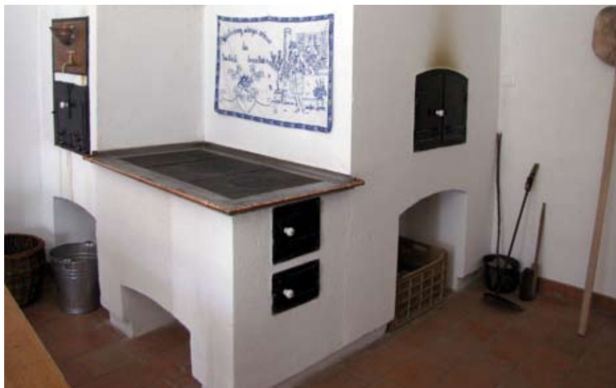
A Fertő-vidékre jellemző tűzhelykombinát: takaréktűzhely, kemence, vízmelegítő a 33. számú ház konyhájában
