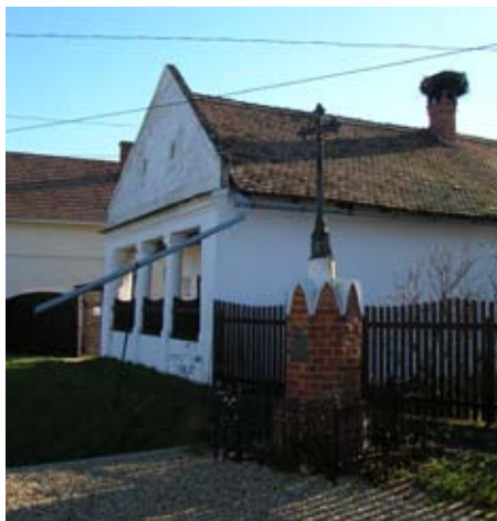
A tájház épülete az utca felől
