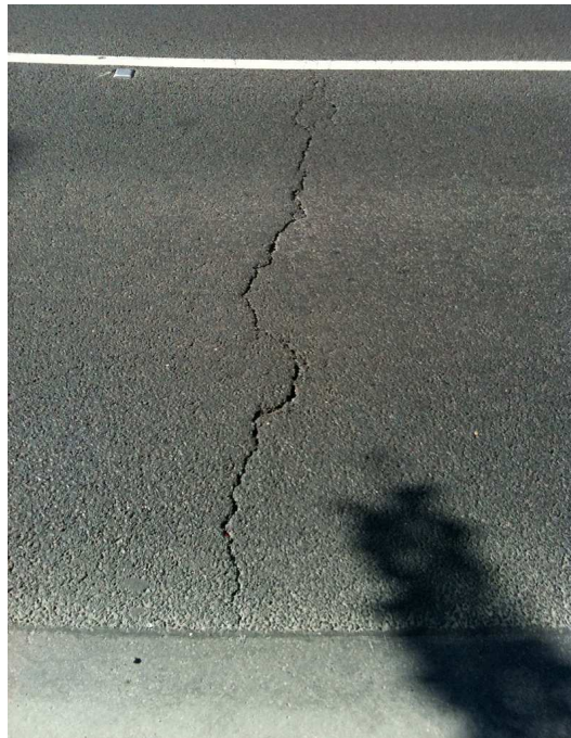
12.1. kép: Teljes sávszélességben futó keresztirányú repedés a Rákóczi úton
