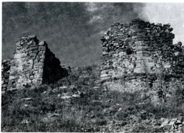
Tres pilastrones, que tal vez formaban dos entradas. Parece que sostenían el solar de la iglesia.
