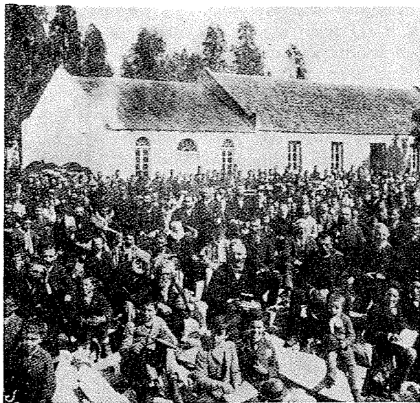
Colocación de la piedra fundamental del Templo de Colonia Valdense. 21 de abril de 1892.
