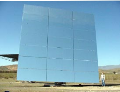
Inabensa 90-m 2 Heliostat
