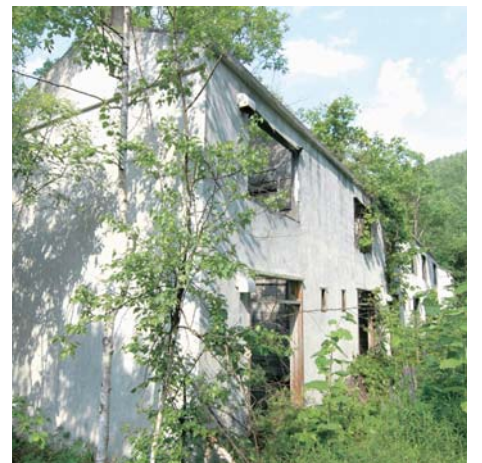
▲道路脇に残っている集合住宅
