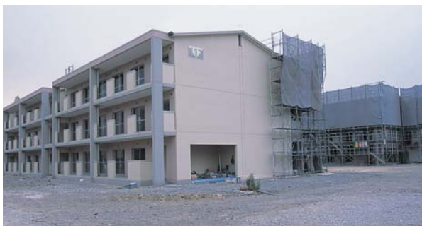
▶工事中の市営改良住宅（松原地区）
