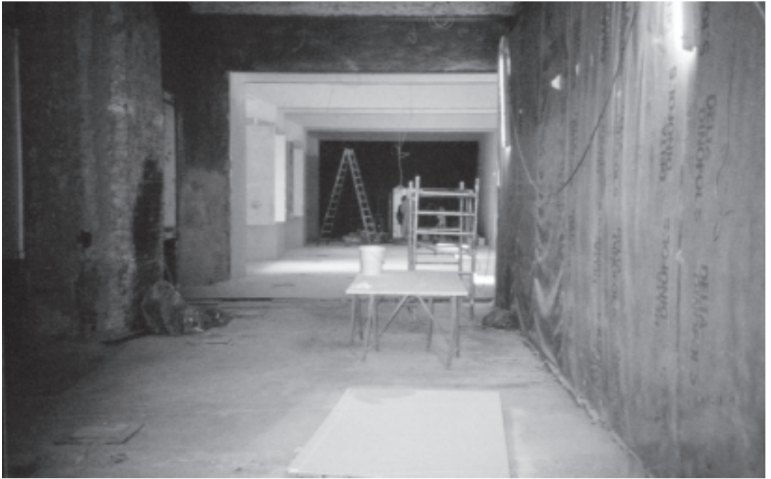
Der Große Tresor während der Bauarbeiten mit eingehausten Münzschränken rechts, 2001.
