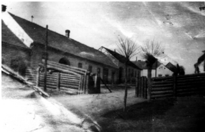
Obr. č. 1. – dřevěné zátarasy na Brněnské ulici
