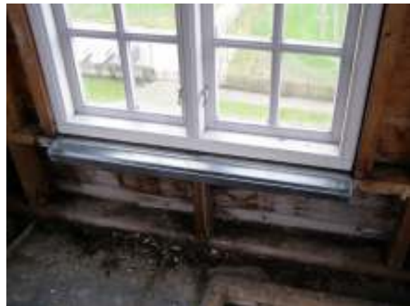
Överst t. v: Lanterninens plåt slagnade kraftigt innan renoveringen. Överst t. h: Ett av lanterninens fönster med kraftigt bortfall av kitt. Observera de bleck man försett bågarna med för att hindra vatteninträngningen. T. v: Den plåt med utkragad kant som täcker glipan mellan lanterninens plåtinklädnad och bågen. Ovan t. h: Kondensränna på insidan av lanterninens fönster.
