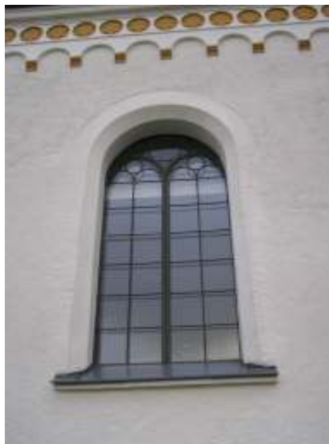
T. v: Detalj av ett av långhusets fönsterbågar med vittrande färgskikt. T. b: Ett av långhusfönstren efter renoveringen. Fönsterbågarna målades med linoljefärg och solbänkarnas plåtavtäckning med Isofinish från Isotrol.
