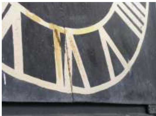
Ovan: En av tornets urtavlor med befintlig bemålning samt prov på mörkare kulör för siffrorna. Den ljusare kulören behölls dock för en tydlig läsbarhet från marken. T. h: Listerken längst upp på hörnlisenerna är utförda av gjutjärn som målats med linoljefärg. Bild före renovering.
