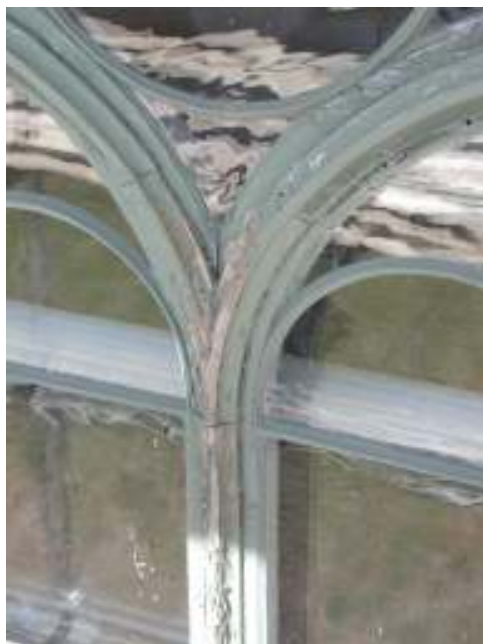
T. v: Detalj av ett av långhusets fönsterbågar med vittrande färgskikt. T. b: Ett av långhusfönstren efter renoveringen. Fönsterbågarna målades med linoljefärg och solbänkarnas plåtavtäckning med Isofinish från Isotrol.
