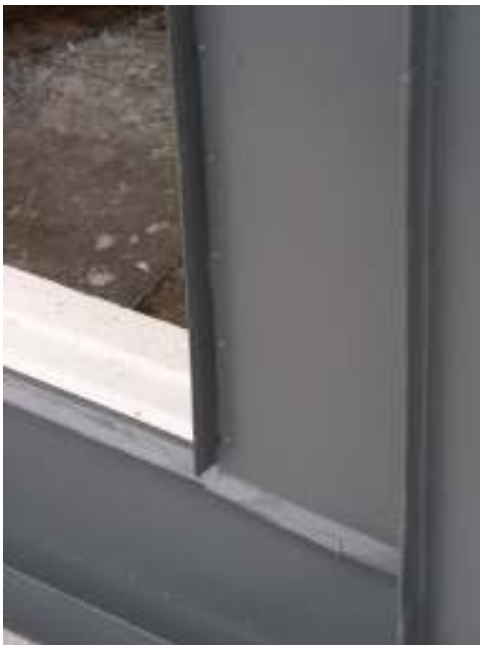
Överst t. v: Lanterninens plåt slagnade kraftigt innan renoveringen. Överst t. h: Ett av lanterninens fönster med kraftigt bortfall av kitt. Observera de bleck man försett bågarna med för att hindra vatteninträngningen. T. v: Den plåt med utkragad kant som täcker glipan mellan lanterninens plåtinklädnad och bågen. Ovan t. h: Kondensränna på insidan av lanterninens fönster.
