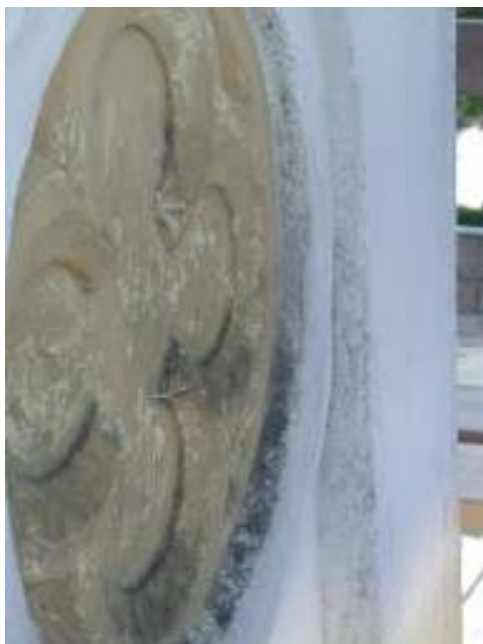
T. v: En av taklistens försänkta rundlar med vittrande färgskikt. Rundlarna anfärgades med Keim purkeristallat för att undvika rinningar på de vita fasaderna. T. b: Algangrepp på norra sidans hörnlisen efter renoveringen.
