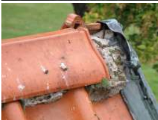
Övre raden: Partiellt lackade vinkelrännor i koppar. Notera tegelpannornas huggna kanter. Undre raden: Saknadnockpanna ersatt med ny. Kopparplåten åter fäst på plats.
