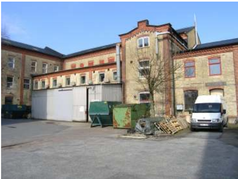
Byggnaderna på Sockerraffinaderiet Öresund tillkom under 1888-1914. Byggnaderna uppfördes ursprungligen med konstruktioner av tegelväggar, gjutjärnspelare med stålbalkar, som tvåvåningslängan bakom plåtskjulet, som är ett maskinrum från 1903, trevåningsbyggnaden bakom denna är raffinaderiet som byggdes 1892 med tegelväggar och träpelare med träbalkar. Byggnaderna har senare byggts om och vilka ursprungliga konstruktioner som bevarats är inte utrett.
