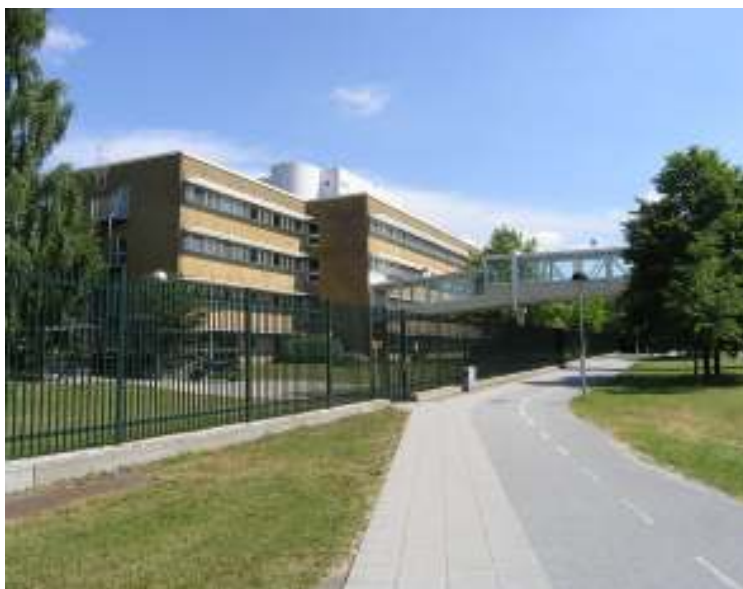
AstraZeneca, kv Reuterdahl 6 och 8. Norra och södra området knyts samman med en förbindelsegång byggd 1990.
