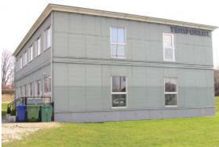
Tillfälliga kontorsmoduler i kv Förla- get. Moduler av denna typ finns på flera områden, Gastelyckan, Brunns- hög och Råbyholm m fl.
