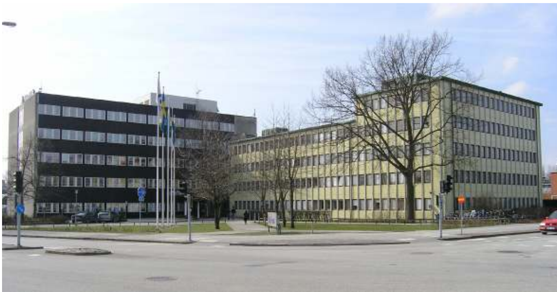
Alfa Lavals kontor från 1959 till höger ritad av Winberg & Högstedt. Tillbyggt i två etapper därefter. Byggnaderna inhyser idag företag inom Tetra Pak.
