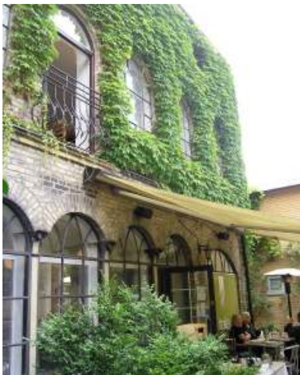
Lilla Fiskaregatan 13 o 11 (Fiskaren 6 o 7). En verkstadsbyggnad från 1878, på gården i mitten av kvarteret. Uppförd i gult tegel med utsökta gjutjärnsdetaljer i form av spetsbågiga gjutjärnsfönster och små lejonhuvud. Idag fungerar byggnaden som restaurang. Ej markerat i föregående bevarandeprogram.
