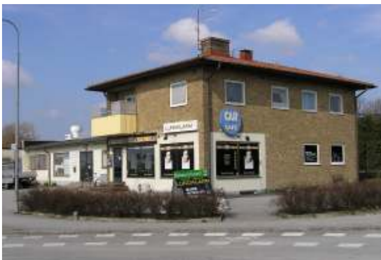
Bilden visar Vespa-Månssons med bostad och verksamhet i samma byggnad.
