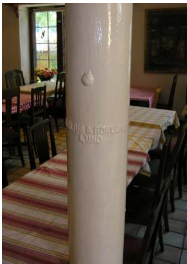
Rudelius & Boklunds mekaniska verkstad levererade gjutjärnspelare till Carl Lundboms garveri på Bredgatan som idag inrymmer restaurang.
