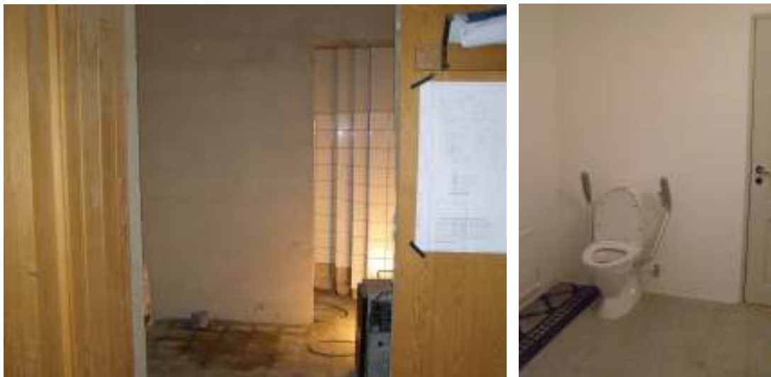
T.v. Hwc och städförråd under arbetets gång. T.h. Väggarna har putsats och avfärgats vita, handikappanpassad toalett, vask och väggspegel har monterats. Öppningen mellan de två utrymmena har försetts med en spegeldörr målad i grå kulör. Notera även golvet som har kompletterats med ljusgrå terrazzoplattor.
