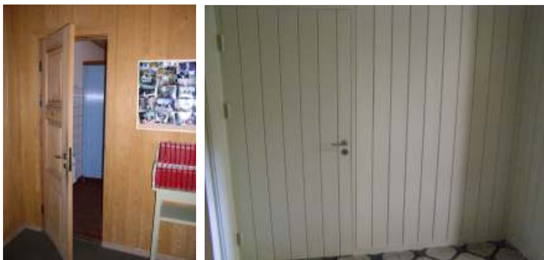
T.v. Entrérummet innan åtgärd. Notera den befintliga dörren och golvet heltäckningsmatta. T.h. Entrérummet efter åtgärd. Viktoriaplattorna framtagna, ny bredare dörr och den vitlaserade panelen har täckmålats med linoljefärg i ljusgrå kulör.
