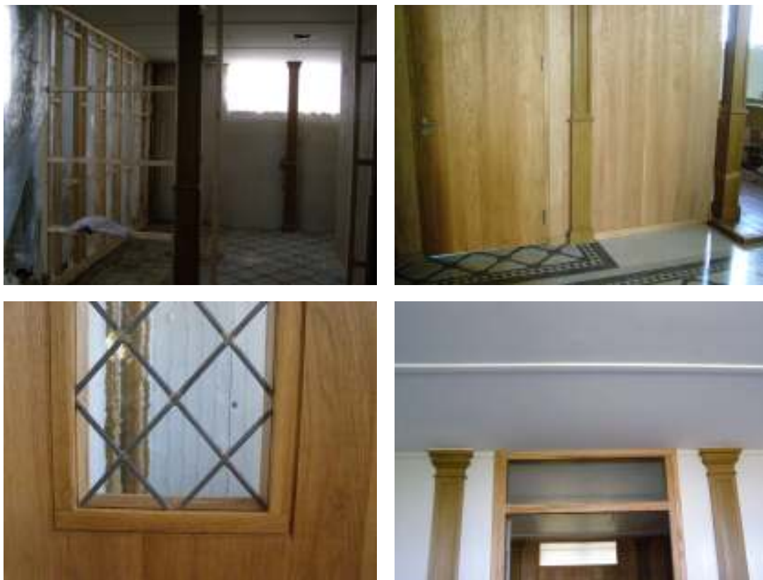
Överst t.v. Läktarunderbyggnaden under uppförande. Regelstommen har passats in mellan befintliga pelare som bär upp läktaren. T.h. Regelstommen kläddes med stående slätspontpanel i oljad ek. Notera utrymmet mellan det gamla viktoriagolvet och bänkinredningens upphöjda trägolv. Nedert t.v. Blyinfattade rombformade fönsterglas sattes i de höga smala fönsteröppningarna in mot kyrkorummet. T.h. För att inte ta bort ljusinsläppet helt från långhusets två bakre fönster placerades överljus över dörrarna på respektive sida mittgången.
