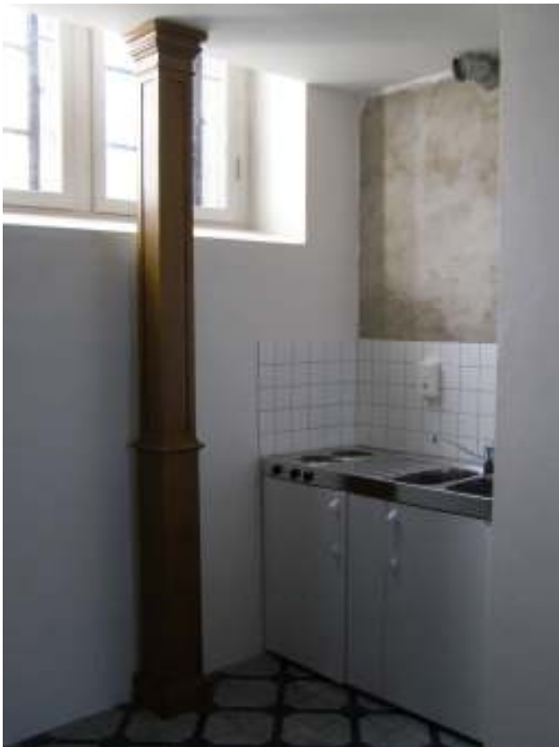
I nischen som uppstod vid utvidgandet av hvc har ett trinette placerats. Väggen ovan är försedd med vitt kakel. Vid tiden för slutbesiktning hade ej skåpsinredningen monterats upp.
