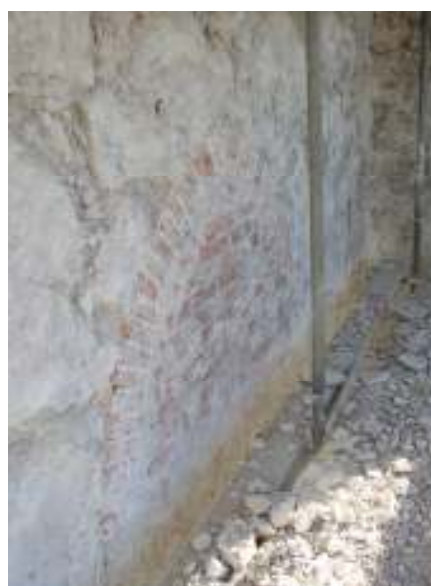
Övre delen på det igenmurade fönstret på tornets södra sida.
