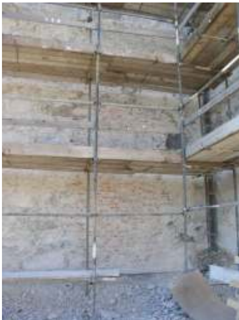
Igenmurad dörröppning på korets norra sida.
