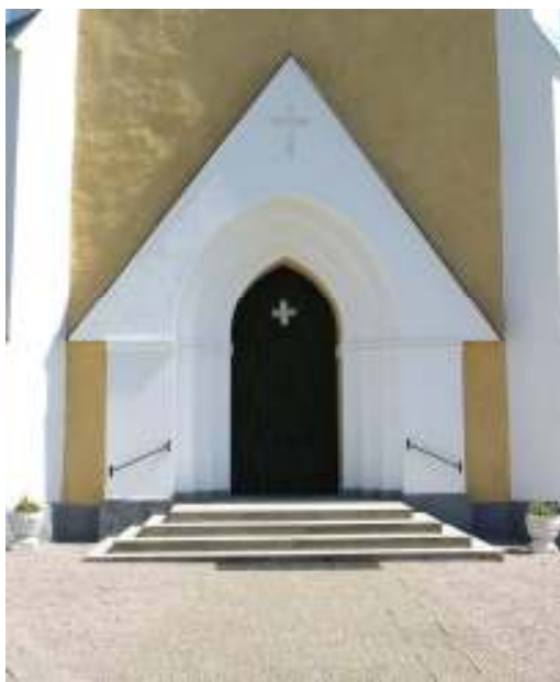
Västportalen efter omputsning och avfärgning, observera det försänkta korset i tympanonfältet.
