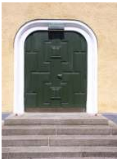
Södra portalen efter ommålning och infällning av fotplåt.
