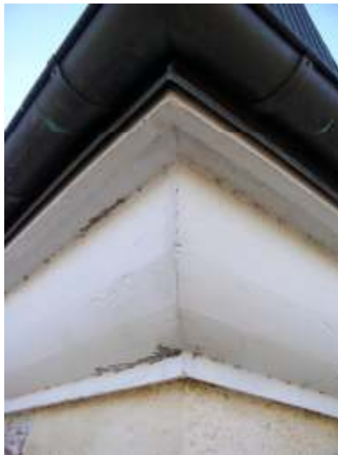
Tornets gesims gjuten i betong.
