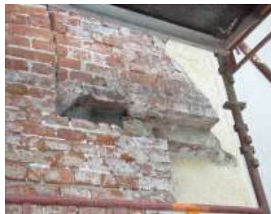
Samma parti som på bilden till vänster efter putsnedknackningen.
