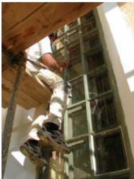
Bortskrapning av löst sittande kitt och färg på fönstersnickerierna.
