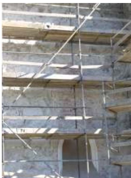
Igenmurat fönster på tornets södra sida.
