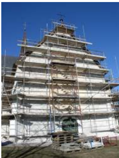
Korets östra fasad med putsen bevarad på det äldre, idag igenmurade, fönstret.
