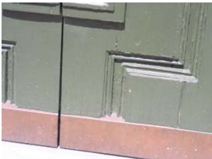
Södra portalens pardörr med infälld fotplåt i koppar.
