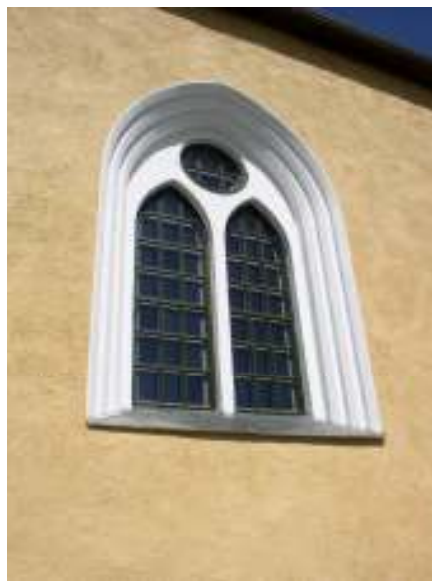
Fönster på långhusets södra fasad efter rengöring och ommålning.
