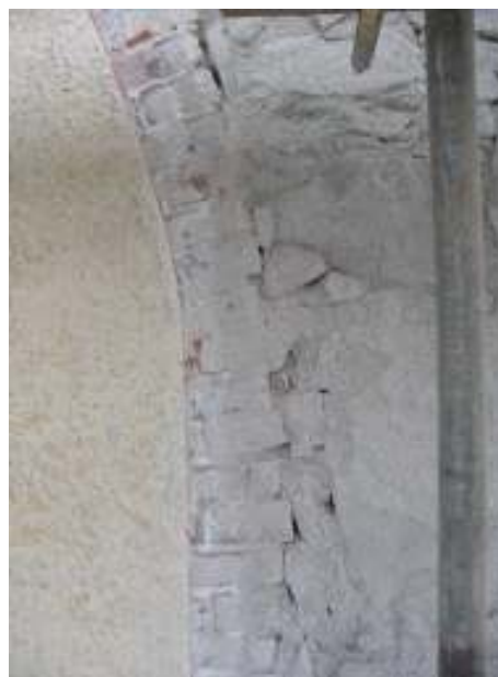
Putsen på det igenmurade fönstret i korets östra fasad hade dålig vidhäftning i kanterna och ca 10 cm fick tas ned.
