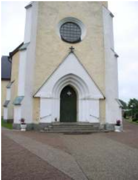
Västportalen före åtgärd.
