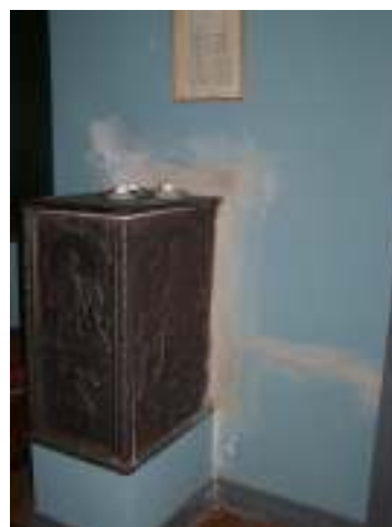
Vägg inne i stugan före och efter putsning av skadan. Målningsarbetet återstår.
