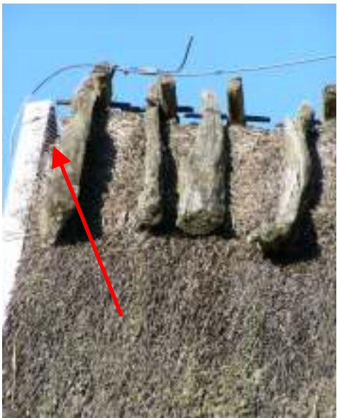
Pilarna visar hål i ryggingen vid södra respektive norra gaveln på östra längan. Nedan syns samma länga före respektive efter omrygging.
