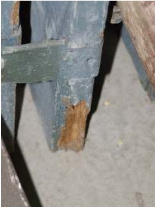
Bild t.v.: Skada i en av bänkinredningens dörrar. Liknande skador fanns i fotbrädor, stödben och bänksitsar.
