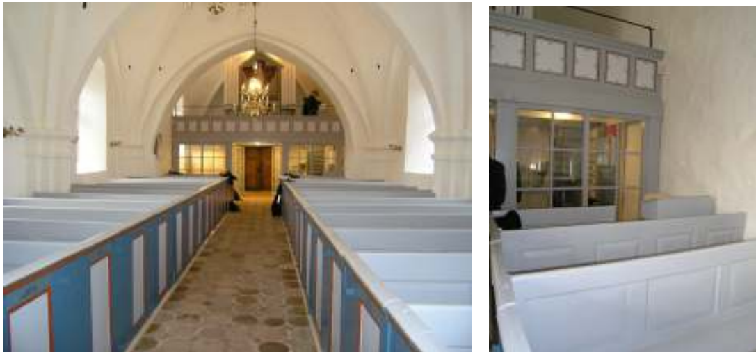
Bild t.v: Vy mot orgelläktaren i väst efter renovering. Två glasade rum har byggts in under läktaren. Nytt tegelgolv har lagts i mittgången och bänkkvarteren har målats om i en färgsättning likt den befintliga.
