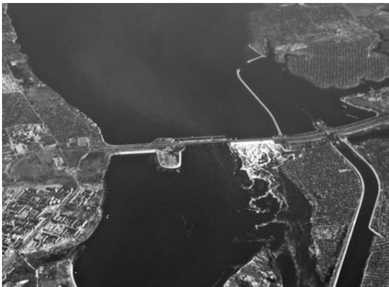
На одном из учебных снимков плотина. Хорошо видны сброс воды и обводной канал
