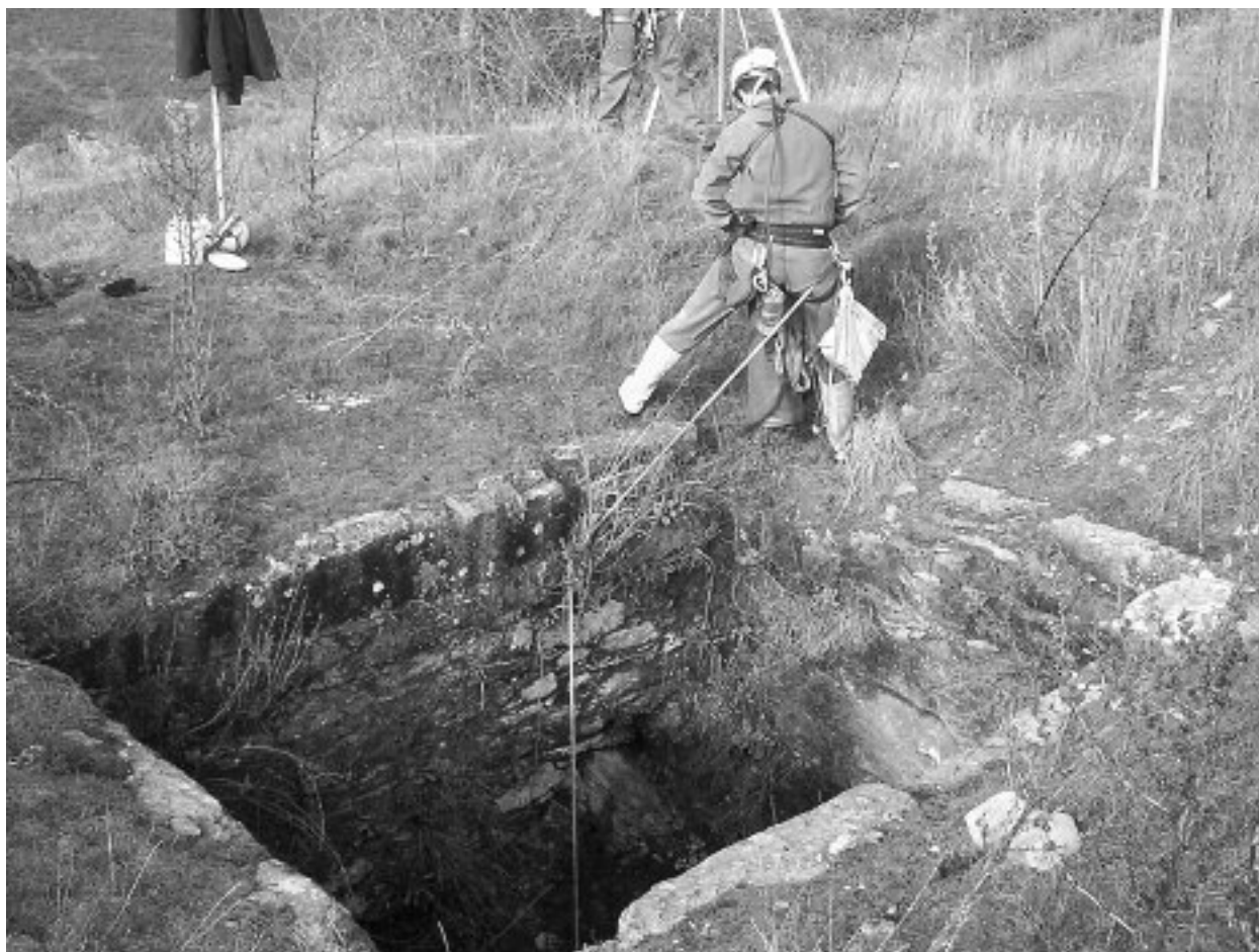
Figura 7. Trabajos de acceso al interior de la mina San José. En su interior se encuentra una interesante muestra de arquitectura minera y encierra una valiosa información geológica, con profusión de filones de baritina intensamente mineralizados.
