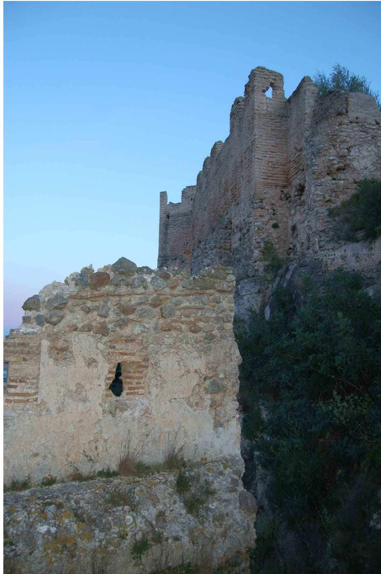
En el arranque de la coracha, en la zona del cuerpo de guardia, se puede apreciar la reforma realizada en el muro. Observamos un recerimiento del mismo, donde quedaron anuladas las antiguas almenas medievales y se hicieron aspilleras. La nueva construcción es de mampostería. En ella se utilizaron también ladrillos.
