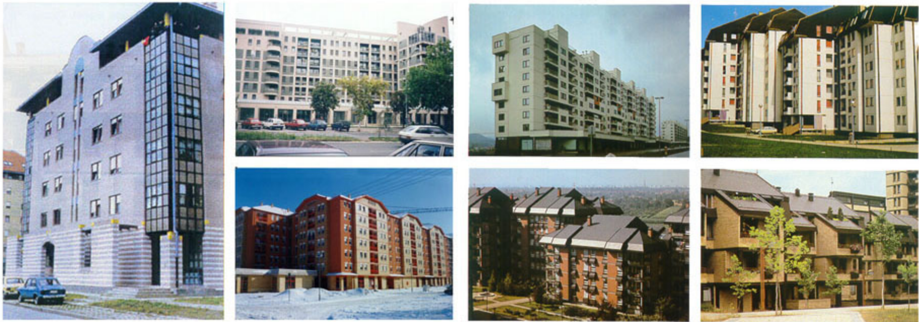
Примери изграђених објеката
