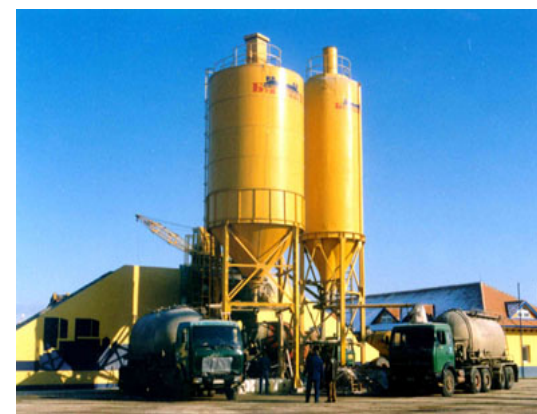
Фабрика бетона на полигону – Нови Сад
