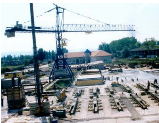
Полигон за производњу елемената – Нови Сад
