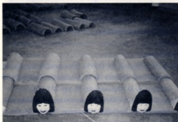
Figura 5. Reconstrucción de un tejado romano con tegulae e imbrices con antifijas.
