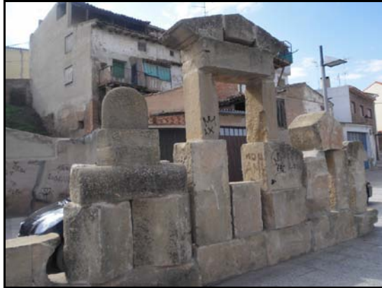
Imagen 39: Sillares del poblado de San Felices, ubicados en la calle Bellavista.
