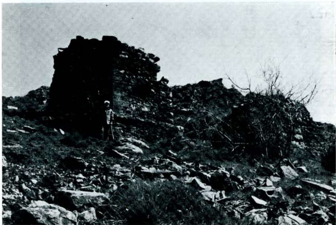
Castillo de Montuerto. Restos de contrafuertes
