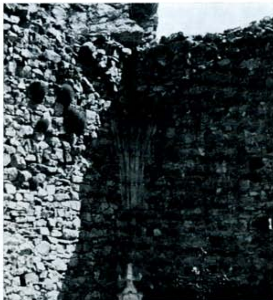
Castillo de Montuerto. Iglesia. Detalle del interior del ábside
