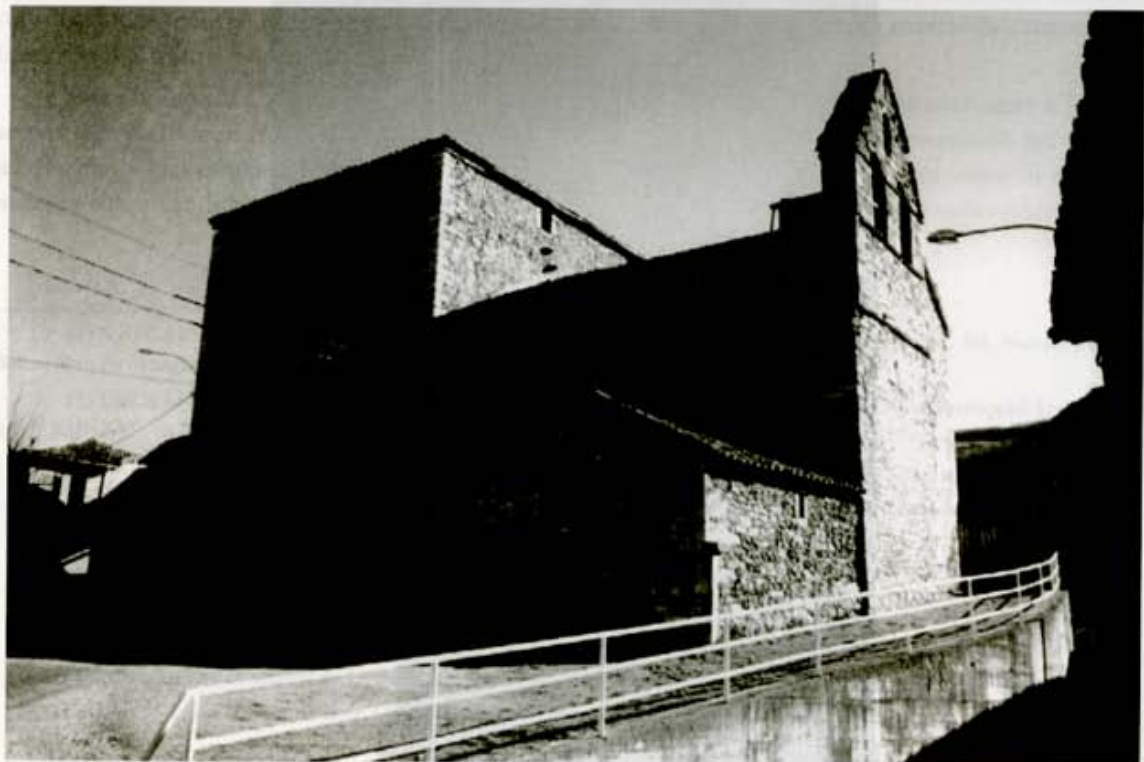
La misma iglesia vista desde el oeste
