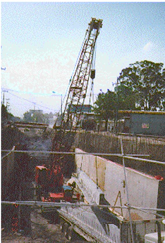
En los tramos subterráneos se ha seguido el proceso de excavación a cielo abierto construyéndose después un cajón de concreto, el cual va a contener las vías y el tránsito de los vagones del metro. Finalmente, se tapa el cajón con tabletas de concreto prefabricado presforzado sobre las cuales se procede a colocar el relleno. Por último, se reconstruyen las avenidas,
