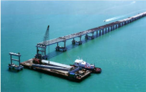
La superestructura en su totalidad está formada a base de elementos prefabricados, siendo estos: 121 cabezales prefabricados de concreto, 496 traveses AASTHO tipo IV modificado, y 8 traveses cajón, así como 124 losas de concreto postensado.
