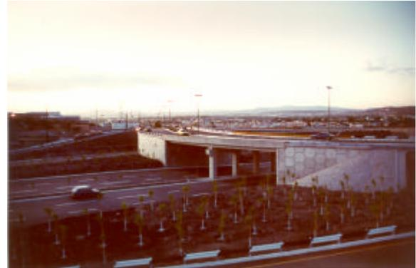
Es un sistema de puentes formado por seis estructuras (cinco puentes vehiculares y un puente peatonal), que permite tener un tráfico fluido en esta zona de la ciudad. Los puentes son totalmente prefabricados, es decir la subestructura está formada por columnas, traveses portantes y estribos doble T tipo Sepsa.
