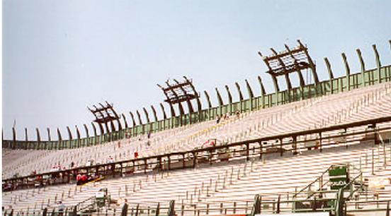
El Foro Sol, cuenta con columnas prefabricadas, travesaños T presforzados y escalones prefabricados, siendo esto una muestra de la versatilidad actual de la construcción industrializada en México.
