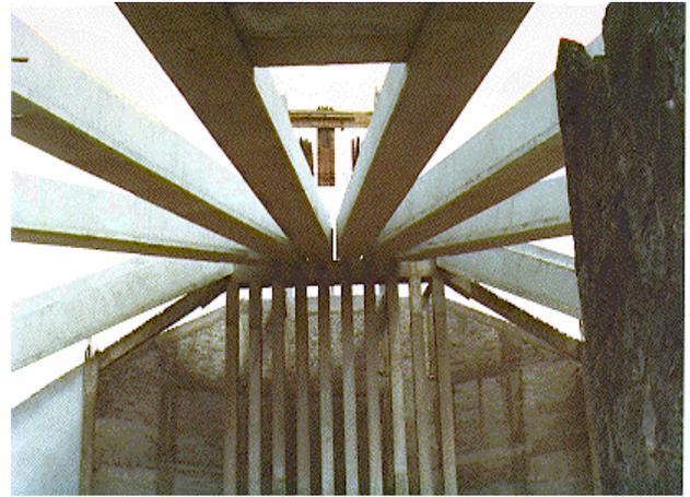
En este caso se utilizaron trabes cajón, cuyo centro aligerado permitió reducir el peso de las mismas, y la colocación de elementos (prelosas) entre ellas, alternando elementos de cubierta opacos con translúcidos y así obtener iluminación cenital.
