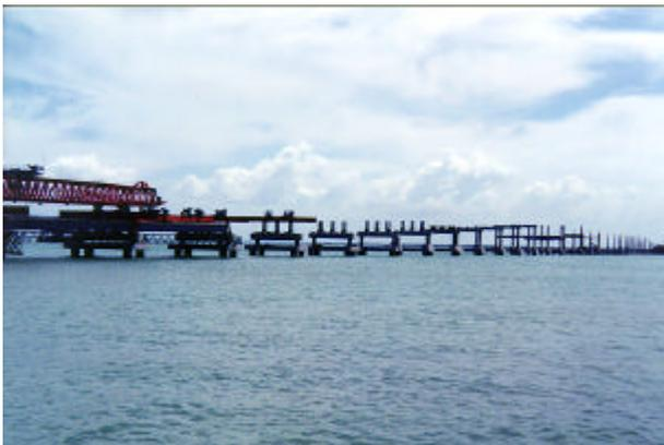
El Montaje de los elementos fue hecho en algunas zonas centrales por un chalán en el cual se monto la grúa y desde esta se colocaron las traveses prefabricadas, y otras secciones se montaron con lanzadoras, las cuales colocaban las traveses e iban avanzando sobre las secciones ya colocadas.
