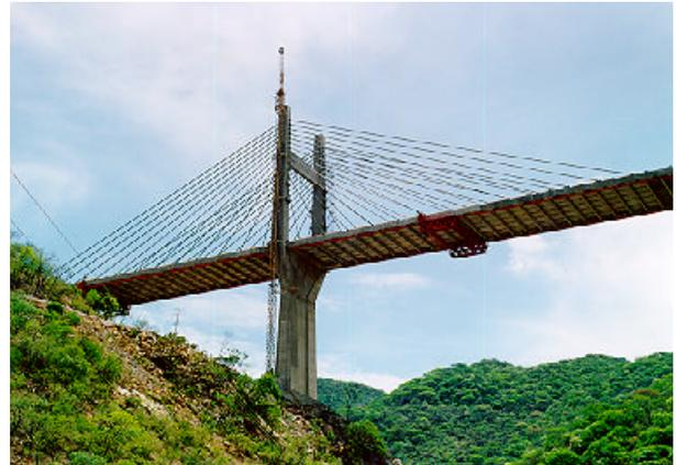
De acuerdo al proyecto, el puente Quetzalapa forma su superestructura mediante el ensamble de los elementos prefabricados. Formado por un total de 871 piezas, el puente Quetzalapa destaca entre los de su género en todo el mundo.
