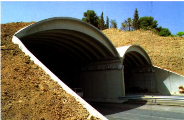
El interior se iluminó debido a la falta de visibilidad en el otro extremo por la curva que describe el túnel. Se hicieron dos túneles paralelos, los cuales son de un solo sentido cada uno, y cuenta en el interior con una zona de banqueta o acotamiento.
