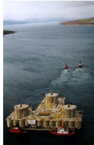
El concreto presforzado posee las características adecuadas para soportar las condiciones extremas de ataque de la corrosión del agua marina, los fuertes vientos que se convierten en grandes tormentas y producen olas que chocan constantemente en la base de las plataformas, y por si fuera poco, en buena parte del año, los icebergs a la deriva pueden llegar a chocar contra las estructuras de las plataformas marinas.
