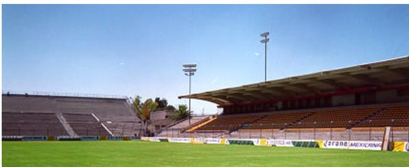
La solución fue prefabricada en forma de herradura cuadrada para contener en el interior las gradas existentes y de esta manera dar continuidad incluso a la isóptica, la cual fue mejorada en la parte alta de las gradas.
