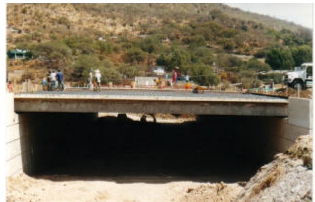
Resuelto a base de vigas con sección "T" prefabricadas y presforzadas de 40 cm de ancho y 85 cm de peralte con una longitud de 17.10 m.
