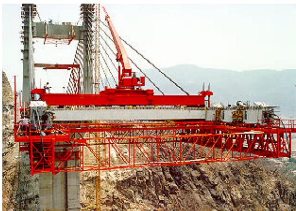
La superestructura en su totalidad está formada con elementos prefabricados, siendo estos, 192 dovelas que al unirse forman dos vigas principales suspendidas por tirantes, corridas a lo largo de todo el puente; un juego de 91 piezas de puente que se apoyan en las vigas principales y un juego de 588 losas prefabricadas que forman la pista de rodamiento apoyadas sobre las piezas del puente.
