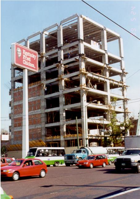
Este edificio llevó un diseño especial muy complejo de muros de contención prefabricados para los tres niveles de estacionamiento, columnas de tres niveles, traves portantes T y T invertida, traves rigidizantes, losas tipo TT para conformar la superestructura del edificio.
