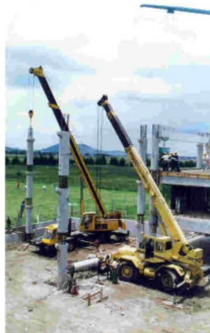
La cimentación está hecha a base de zapatas corridas, presentando una innovación en la conexión de la cimentación con las columnas. Los trabajos de cimentación fueron ejecutados por la contratista de Obra civil, según los datos técnicos de la mecánica de suelos y la propuesta de la empresa prefabricadora, desplantándose a 1.80 mts, colando los dados
