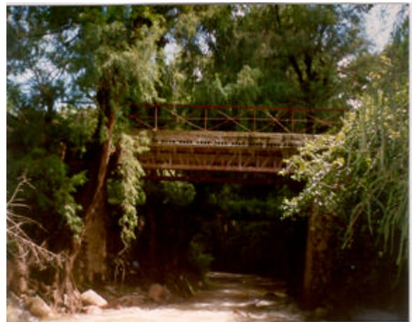
La superficie de rodamiento está construida con sistema de vigueta y bovedilla y los elementos principales portantes son armaduras a base de perfiles de lámina doblada.
