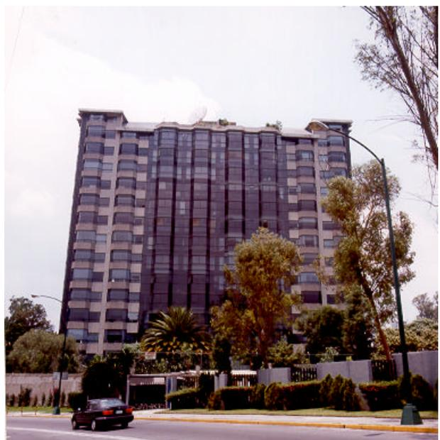
Estructura híbrida, columnas y traves coladas en sitio y las losas se construyeron a base de vigueta y bovedilla de cemento arena.
