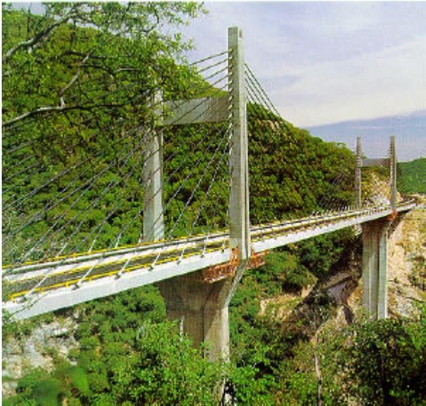
Es del tipo atirantado, construido sobre una cañada a una altura de 115 m, con una longitud de 424 m, y un ancho de 21.4 m, permitiendo la circulación de 4 carriles.
