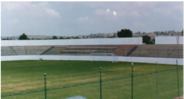
Montaje de Grada prefabricada y presforzada con sección de 60 cm de peralte por 90 cm de ancho de 7.50 m de longitud para tribuna de estadio Brujo construido en la ciudad de San Francisco del Rincón, Gto., en el año de 1994.
