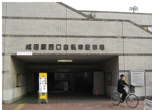
利用者の多い JR 成田駅西口駐輪場
