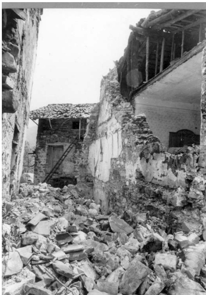
Porušeni objekti v Breginju.
