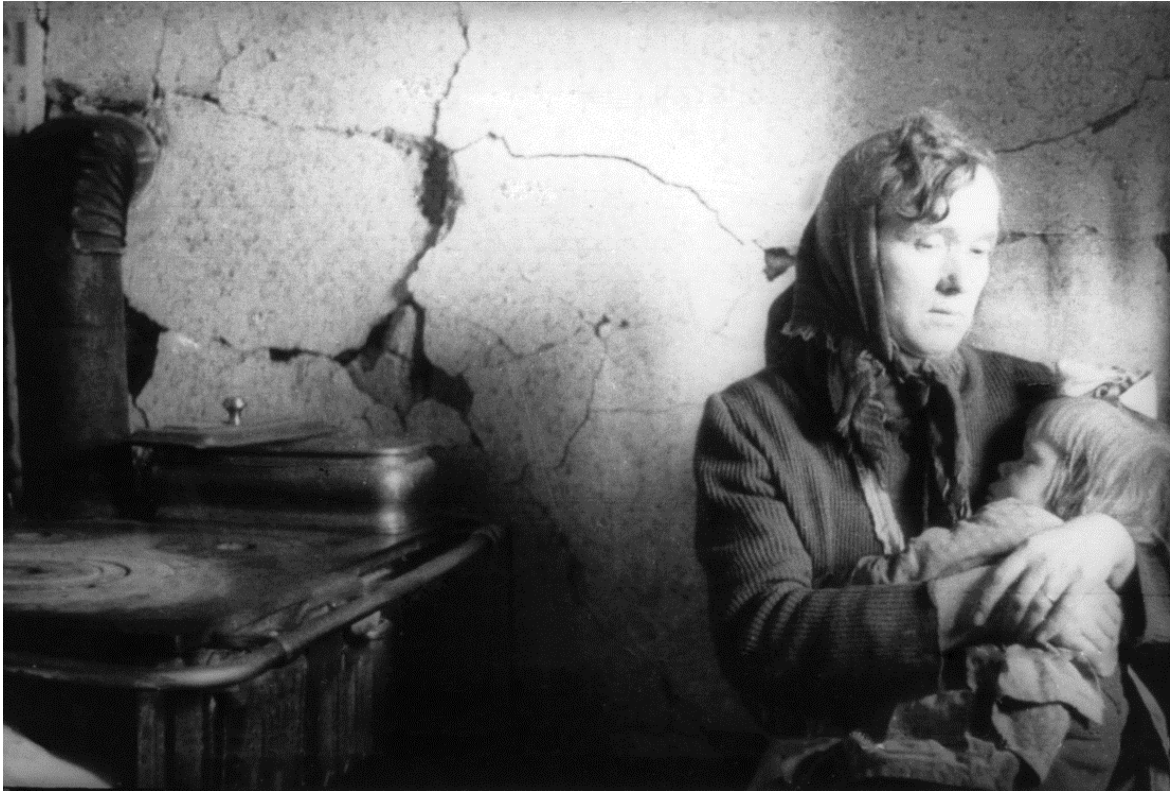
Poškodbe ob ilirskobistriškem potresu.
