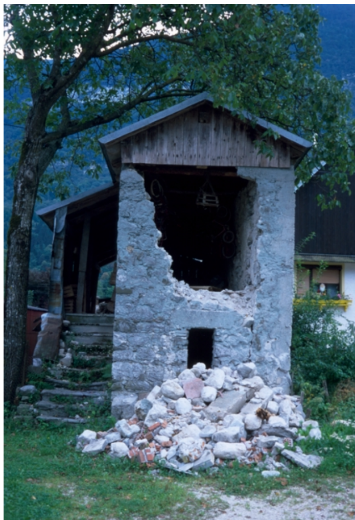
Uničena zgradba v Čezsoči
