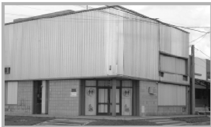
Edificio de la Administración
