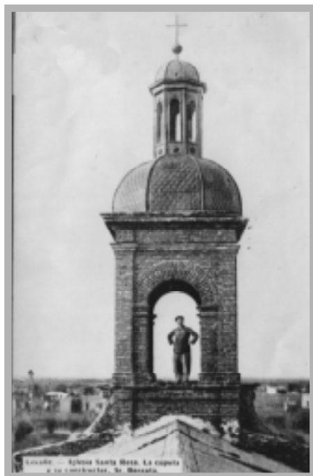
La cúpula y su constructor, Sr. Borgata
