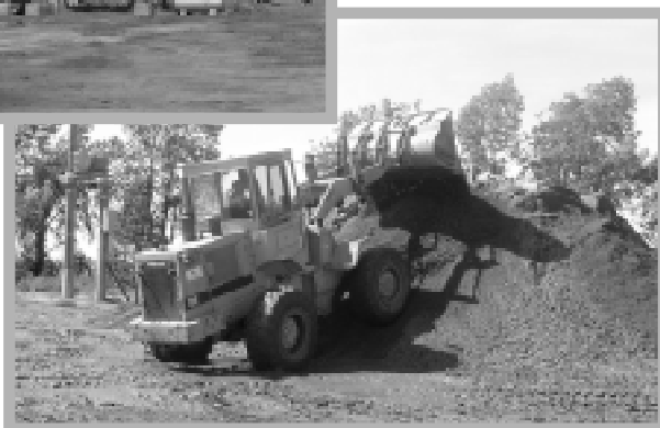
Obrador instalado y trabajos de alteos en Ruta provincial 10 realizados por la Empresa Boetto y Buttigliengo SA
