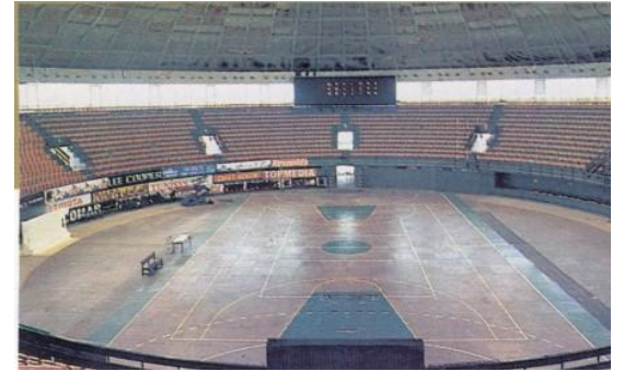
Vue intérieure du Palais des Sports - 5.000 places
